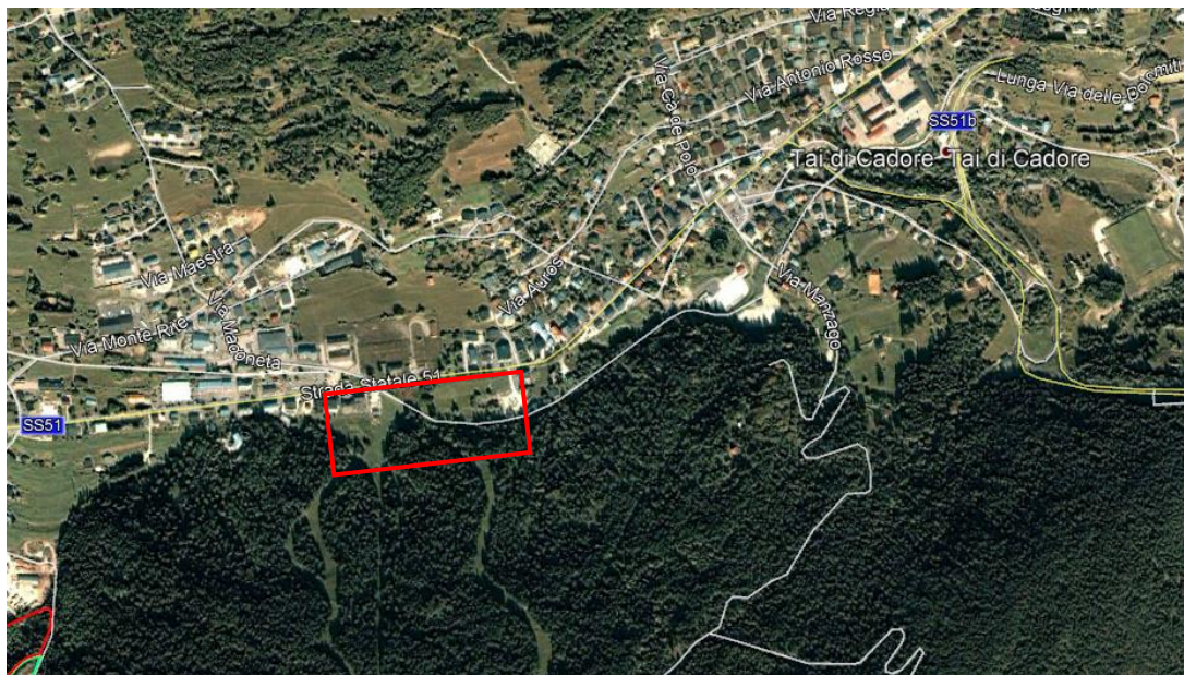
Figura 11 - Foto aerea del deposito temporaneo T1
