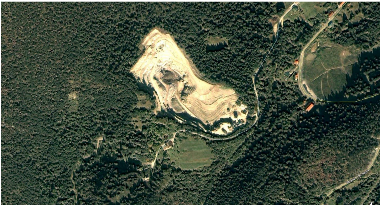
Figura 6 – Particolare deposito definitivo (Cava Damos) su ortofoto
