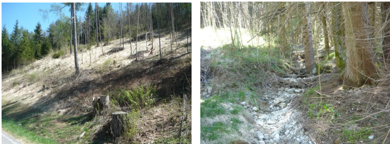
Figura 37 – Area d'imbocco della galleria artificiale e impluvio interferente alla progressiva 00+200 km
