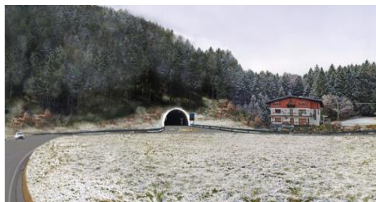
Foto 7 Visuale dell'elemento di raccordo ad Est, direzione Longarone
