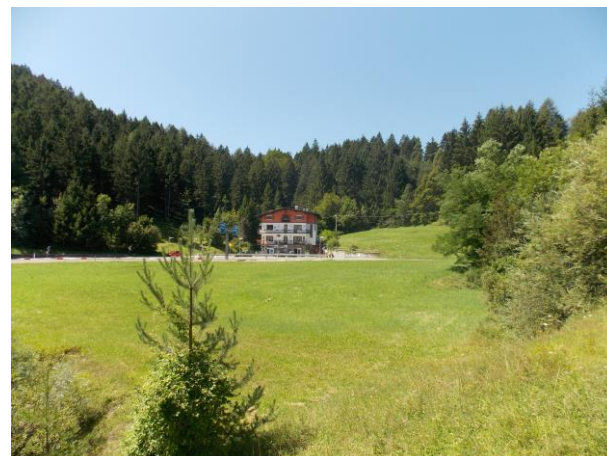
Foto 6 Visuale del posizionamento dell'elemento di raccordo ad Est, direzione Longarone
