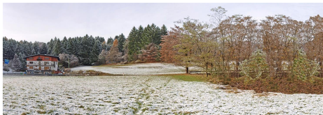
Figura 43: Area di intervento direzione Longarone, imbocco sud-est
