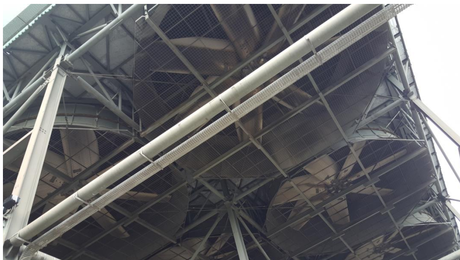
Figura 8 - Vista dei ventilatori del condensatore ad aria
