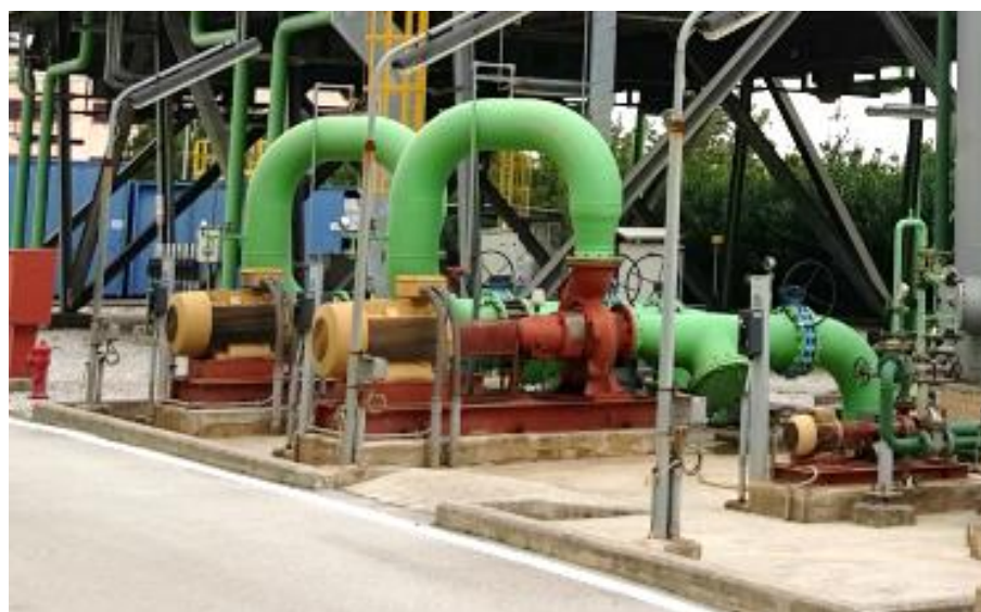
Figura 10 - Sezione di pompaggio dell'impianto acqua raffreddamento impianti
