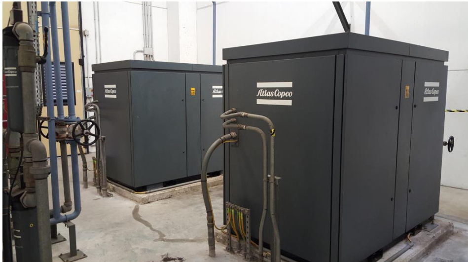
Figura 11 - Compressori Atlas Copco raffreddati ad acqua presenti nella centrale di generazione di aria compressa
