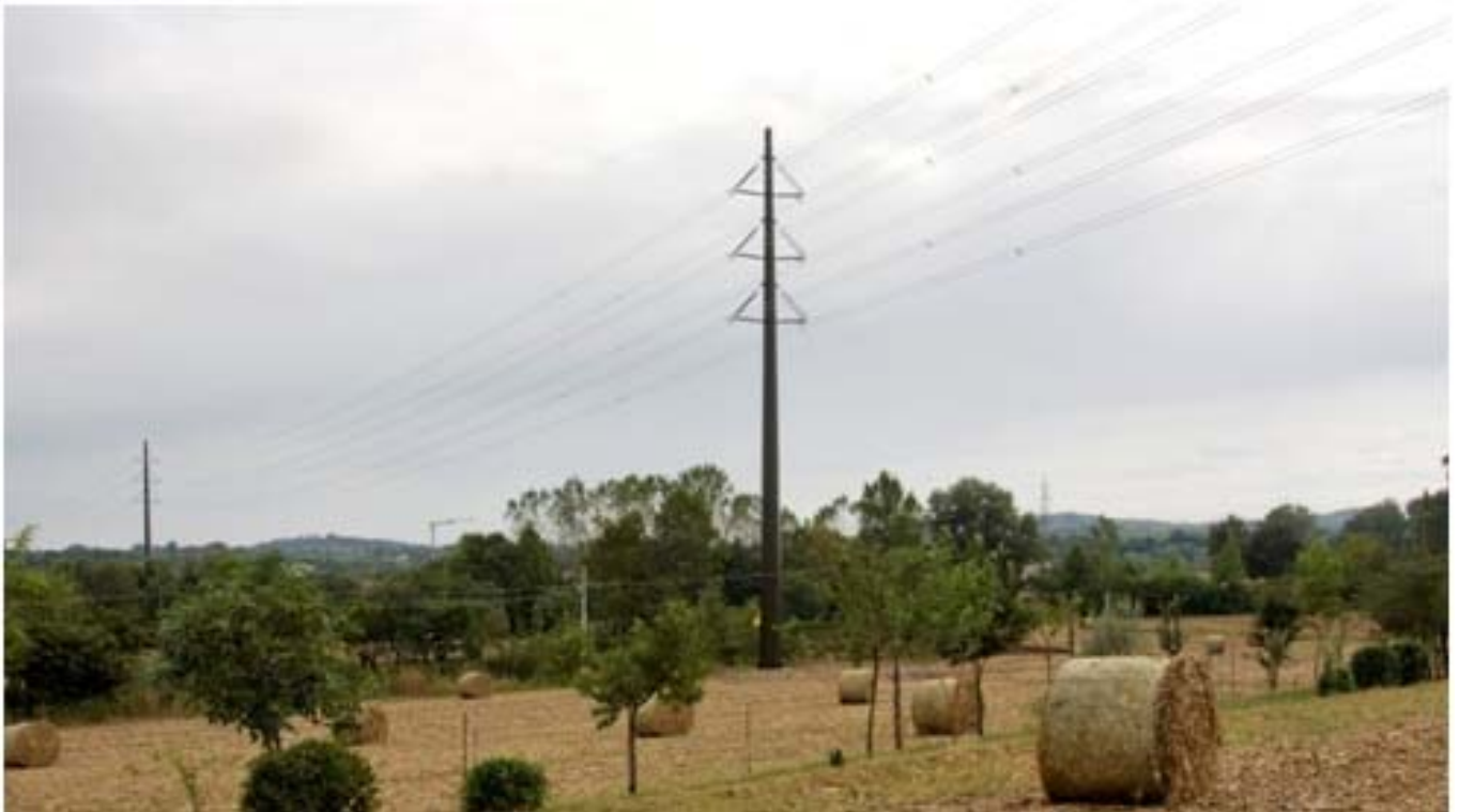
Figura 2.4. Esempio di sostegno tubolare
