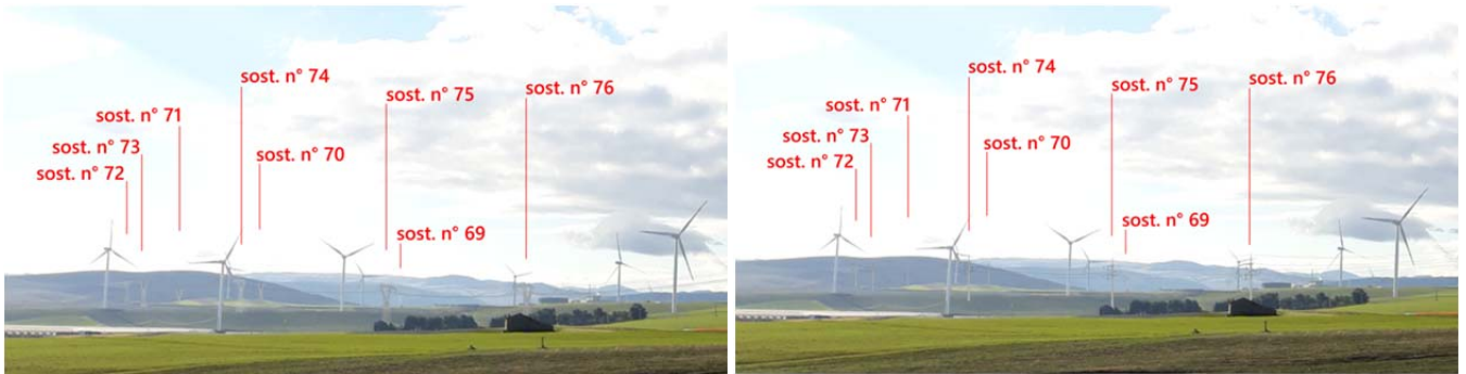
Figura 5.10. Punto di Vista P4 – Dettaglio tra il tracciato di progetto autorizzato con sostegni di tipo reticolare (a sinistra) e con l’inserimento di un sostegno monostelo (a destra)
