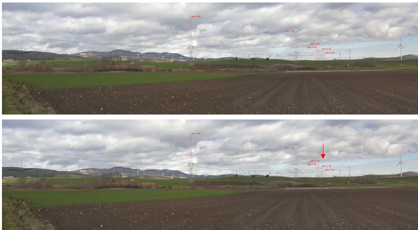
Figura 5.6. Punto di Vista P2 – Confronto tra il tracciato di progetto autorizzato con sostegni di tipo reticolare (sopra) e con l’inserimento di un sostegno monostelo (sotto)
