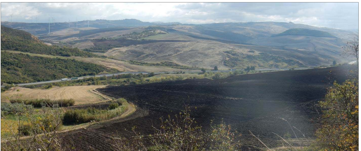
Figura 3.4. Vista da nord-est verso sud-ovest del corridoio infrastrutturale dell'A16 nella valle del Torrente Calaggio
