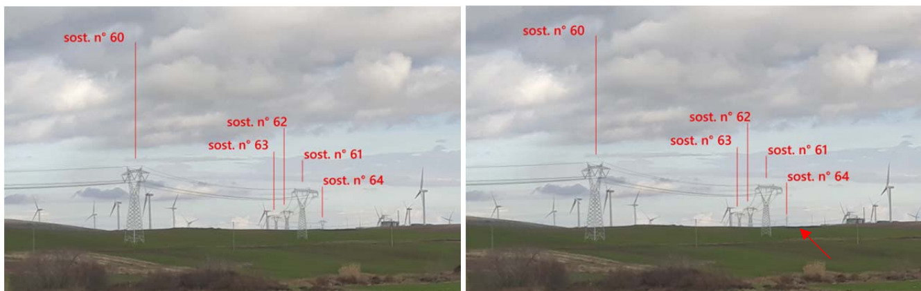
Figura 5.7. Punto di Vista P2 – Dettaglio tra il tracciato di progetto autorizzato con sostegni di tipo reticolare (a sinistra) e con l’inserimento di un sostegno monostelo (a destra)
