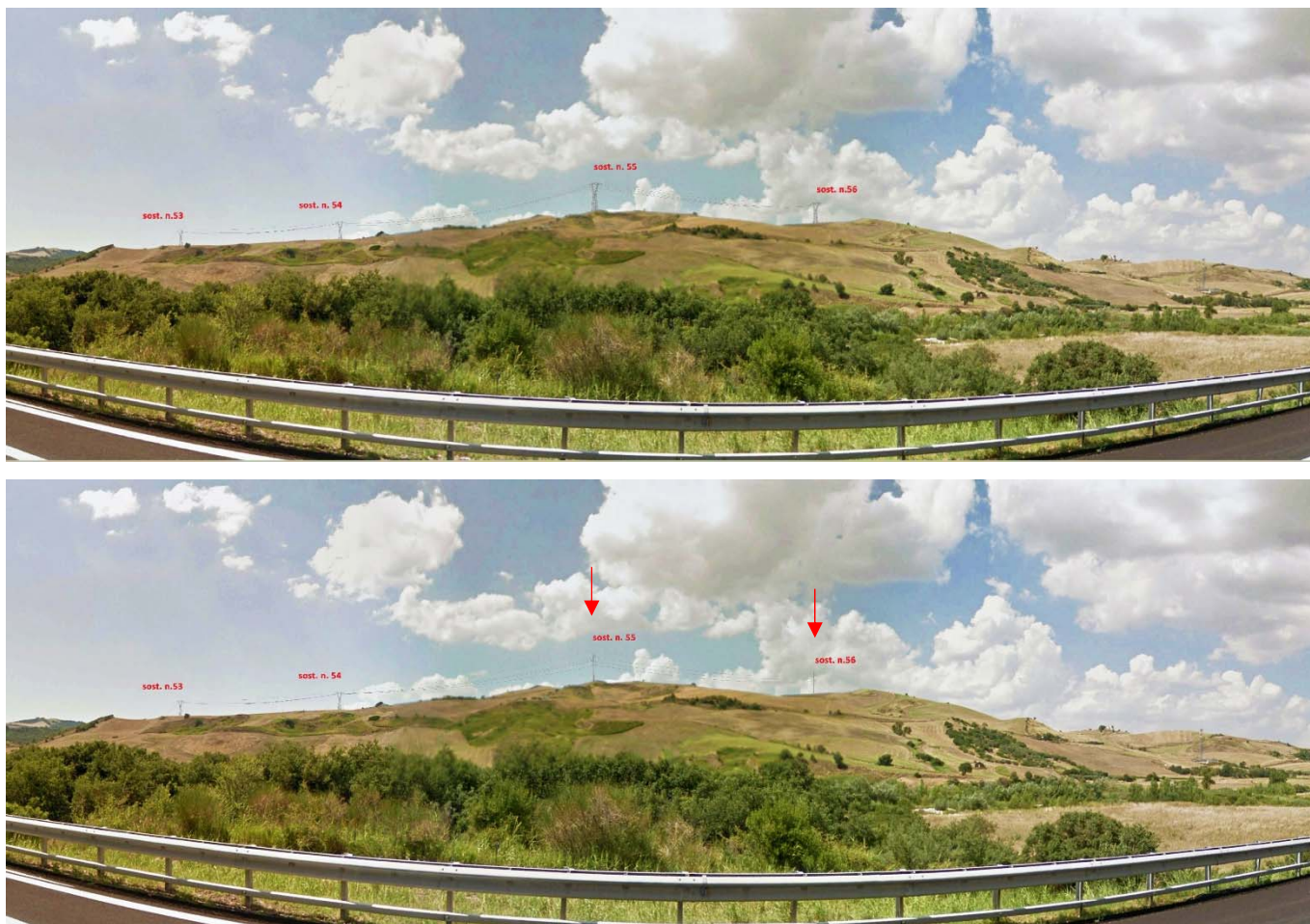
Figura 5.5. Punto di Vista P1 – Confronto tra il tracciato in progetto autorizzato con sostegni di tipo reticolare (sopra) e con l’inserimento isolato di due sostegni monostelo (sotto)
