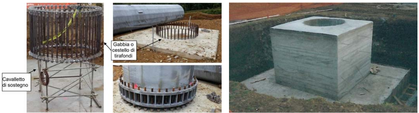
Figura 2.7. Fondazioni a gabbia o cestello (sinistra) e a bicchiere (destra)
