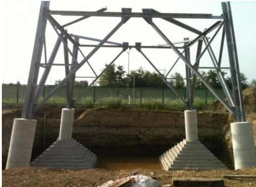
Figura 2.6. Fondazioni a piedini separati
