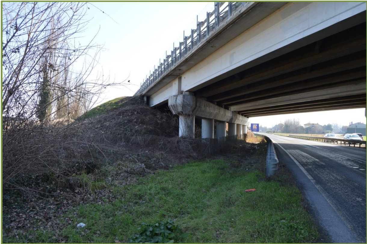
SP253R prima del ponte dell'A14DIR in direzione Bagnacavallo
