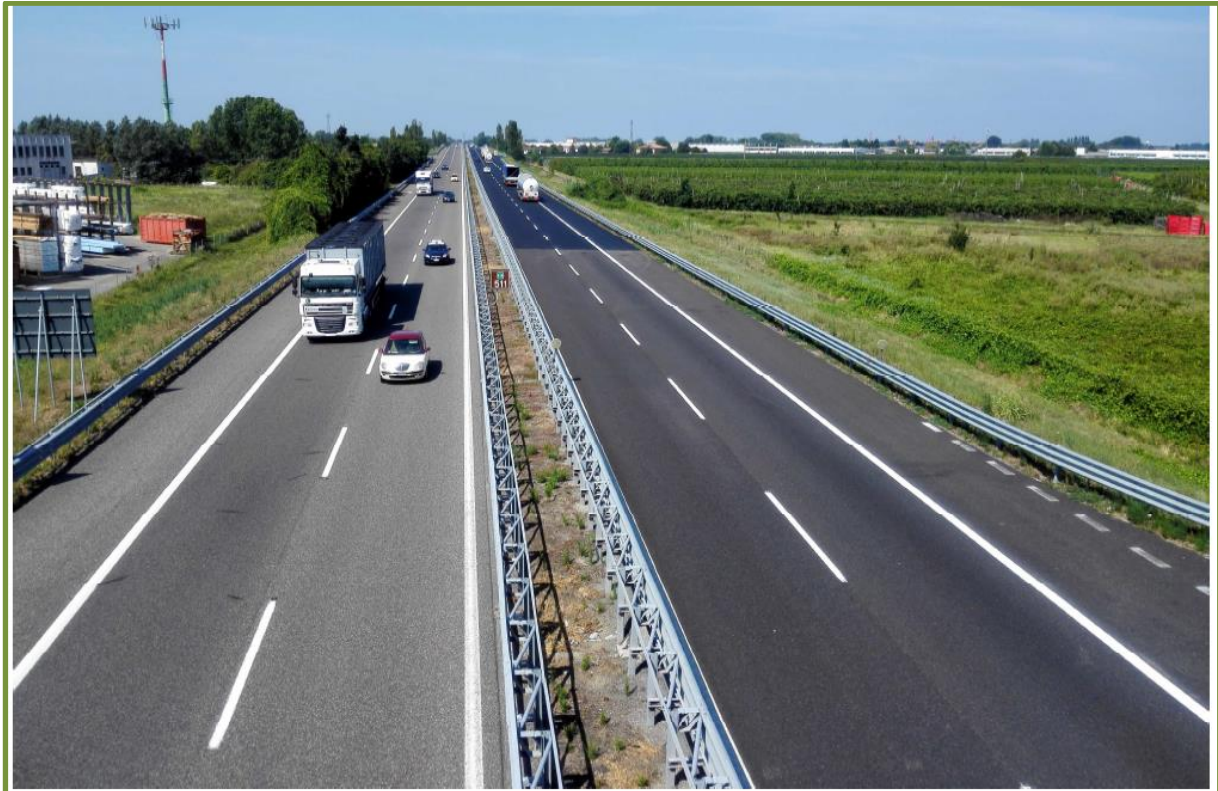
A14DIR - in dx direzione Bo inizio rampa ponte su SP253R)
