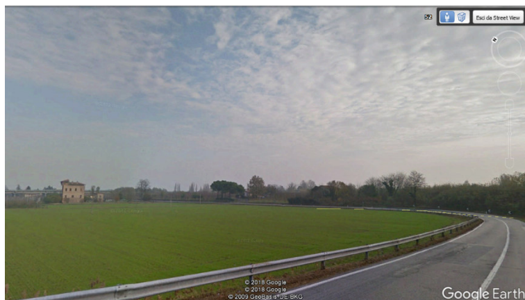
Img. 7.1.13 -Vista dell'argine del Lamone dalla SP 25
