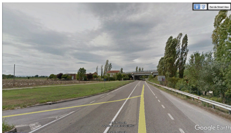
Img. 7.1.7 - Vista dell'intersezione dalla SP253 San Vitale, in direzione sudovest
