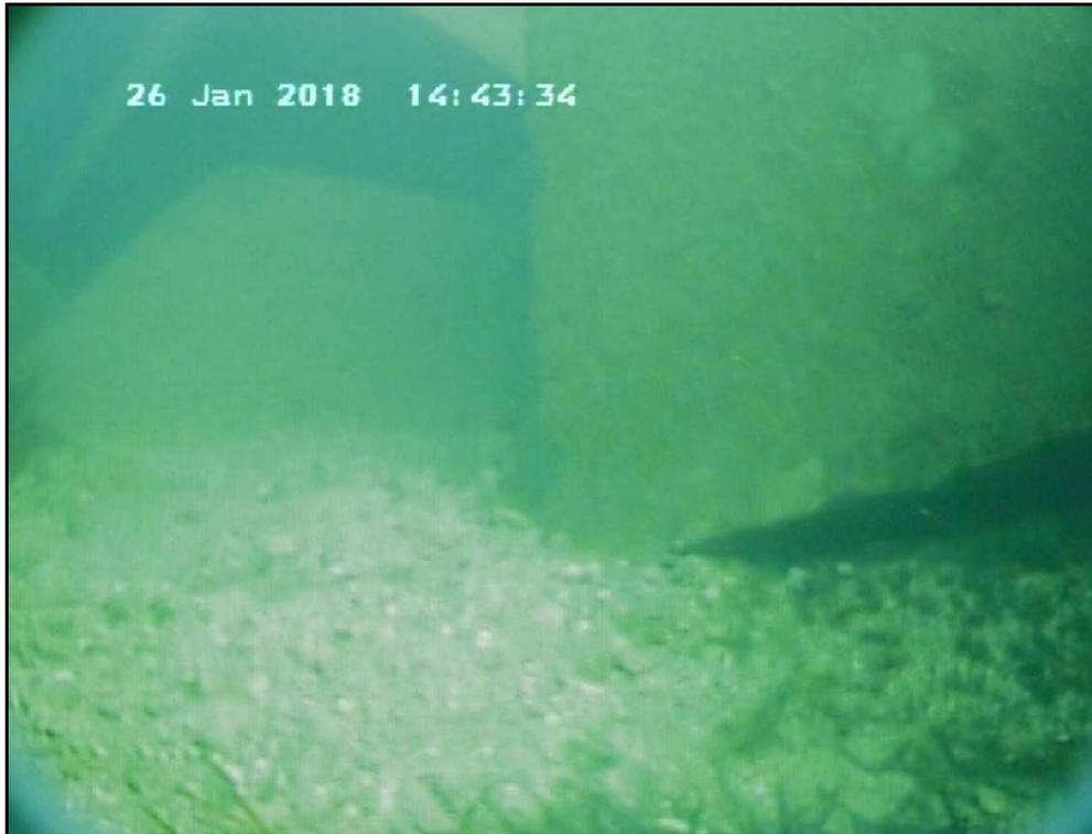
*Fig.12 - Immagine estratta dall'indagine video. Sono evidenti dei piccoli accumuli di sabbia e ghiaia derivanti probabilmente da recenti mareggiate.*
