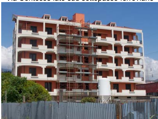
Nuova edificazione Via Stagno fronte cantiere
