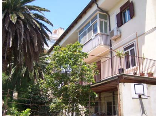
Facciata interno cortile lato cantiere
