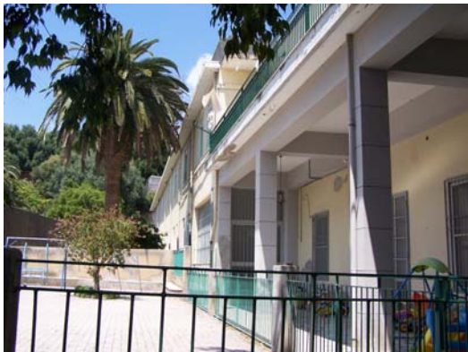
Facciata interna destinata alle attività ludiche
