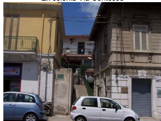
Edificato Via Consolare Valeria a sud area cantiere
