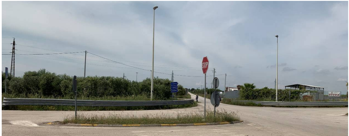
Foto P5.C: Vista della SP84 (Regio Braccio Cerignola –Ascoli Satriano) interessato dal passaggio del cavidotto esterno
