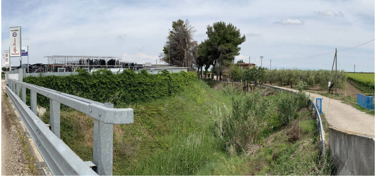
Foto P6.A: Vista della Marana Castello verso valle dalla complanare della SS16, nel tratto in cui verrà attraversata dal cavidotto esterno
