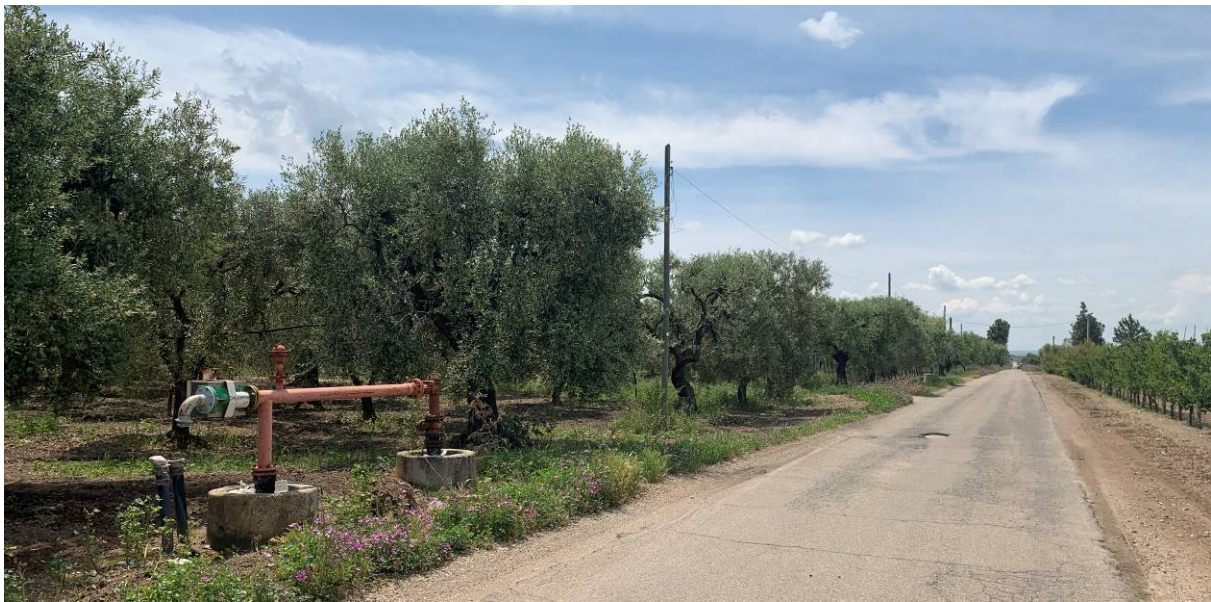
Foto P12.A: Vista della viabilità secondaria interessata dal passaggio del cavidotto esterno, in prossimità della sottostazione
