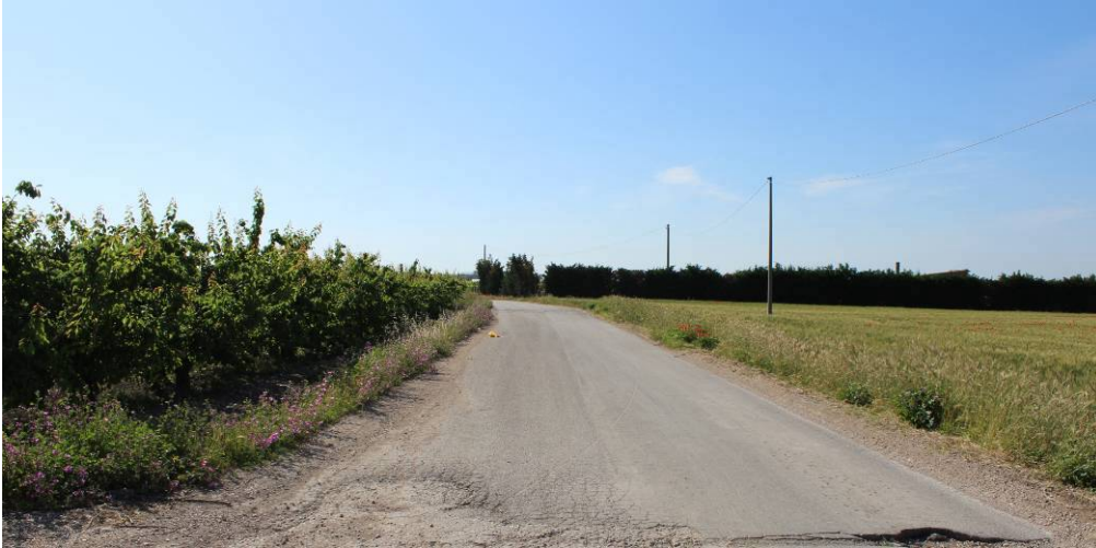
Foto P8.B: Vista della viabilità secondaria interessata dal passaggio del cavidotto interno, in direzione NW/SE. Località Masseria Viro
