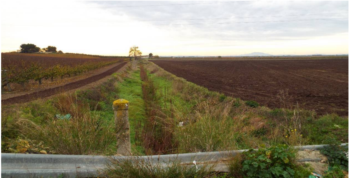
Foto P4.B: Vista della Marana Castello verso monte
