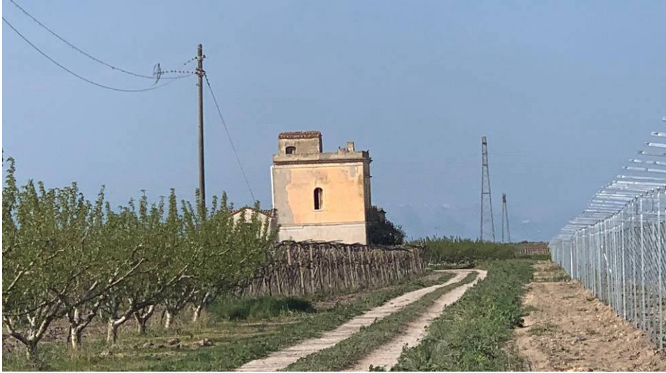
Foto P2: Masseria San Michele alle vigne presente all'interno dell'area d'impianto. (Segnalata nel PPTR) Si presenta un immobile degradato/abbandonato
