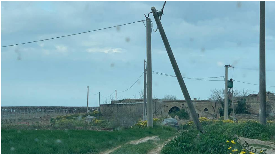
Foto P1: Masseria Posta del Toro presente all'interno dell'area d'impianto. (Segnalata nel PPTR) Si presenta un rudere abbandonato
