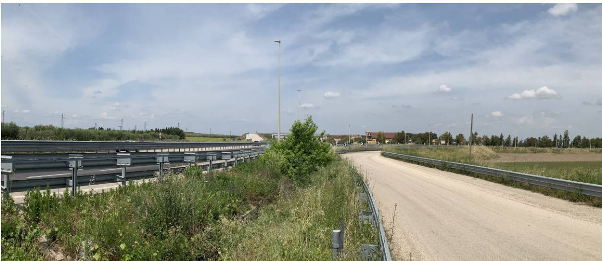
Foto P7.A: Vista della complanare alla SS16, nel tratto che costeggia il confine dell'area di progetto verso Foggia
