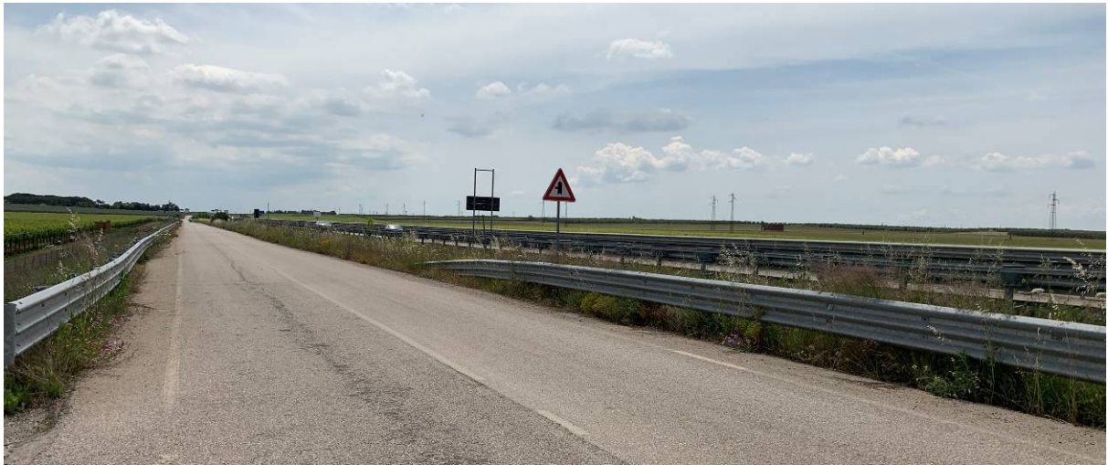
Foto P6.D: Vista della complanare della SS16, nel tratto in cui verrà attraversata dal cavidotto esterno, in direzione di Cerignola
