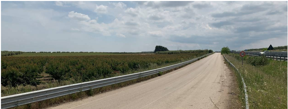
Foto P7.C: Vista della complanare alla SS16, dal confine dell'area di progetto, verso Cerignola
