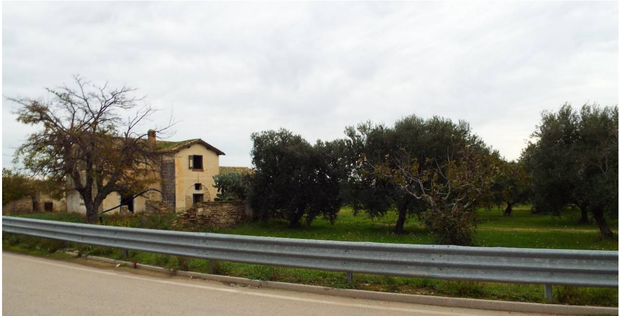
Foto V9 Ante Operam: Vista dalla complanare della SS 16. Confine sud-ovest dell'area di progetto, in direzione dell'area di impianto
