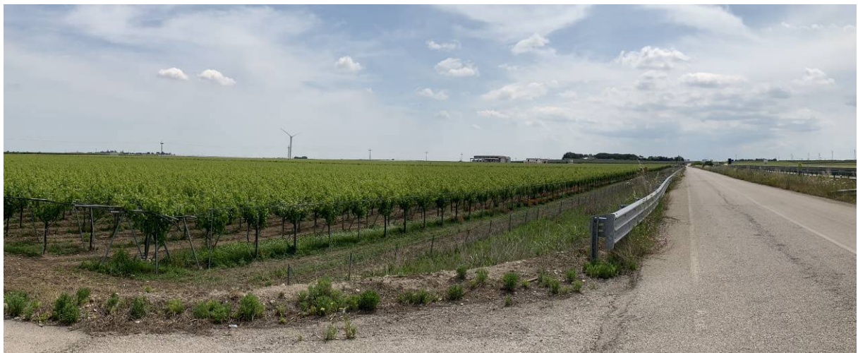
Foto P6.C Vista della complanare della SS16, nel tratto in cui verrà attraversata dal cavidotto esterno. In direzione degli aerogeneratori WTG11, 12, 13
