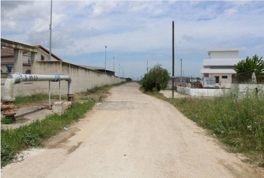
Foto P11: Vista della viabilità secondaria di accesso al parco eolico dalla viabilità di servizio della SS 16 in direzione della turbina WTG11, località Fontanelle
