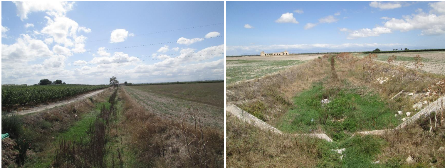
Figura 12 – 13 Marana Castello adiacente all'impianto priva di vegetazione e ormai in asciutta
