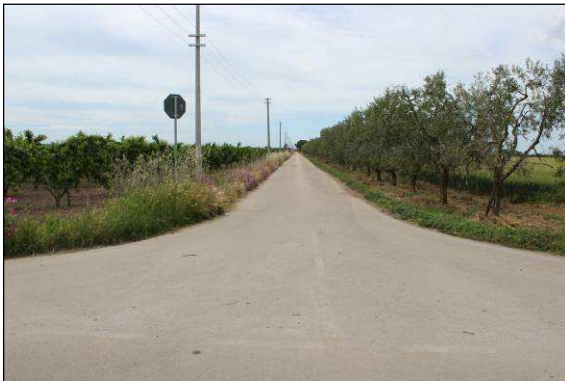
44. Elettrodotta lungo la strada comunale Contessa, località Mass. Cannone
