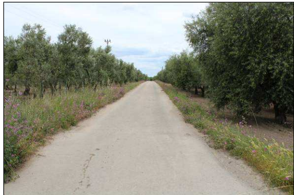
45. Elettrodotta lungo la strada comunale Contessa, località Mass. Cannone
