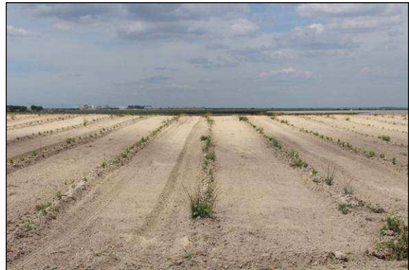
32. Area di installazione della turbina 11, località Masseria Specchio
