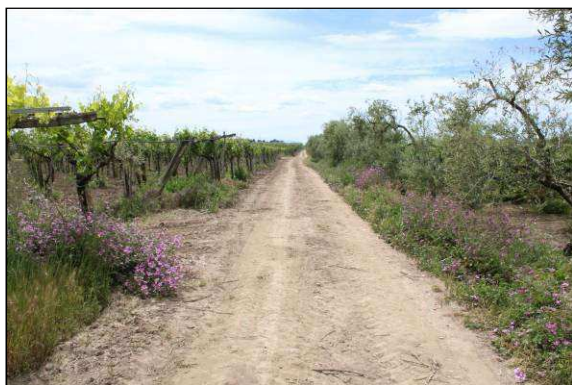
36. Elettrodotto tra le turbine 12 e 13, località Tonnamarella
