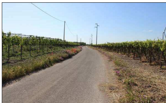
3. Elettrodotto lungo la SP 72, località Salice
