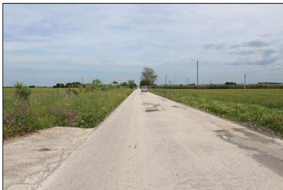
42. Elettrodotto lungo la SP 88, località Mass. Posticciola
