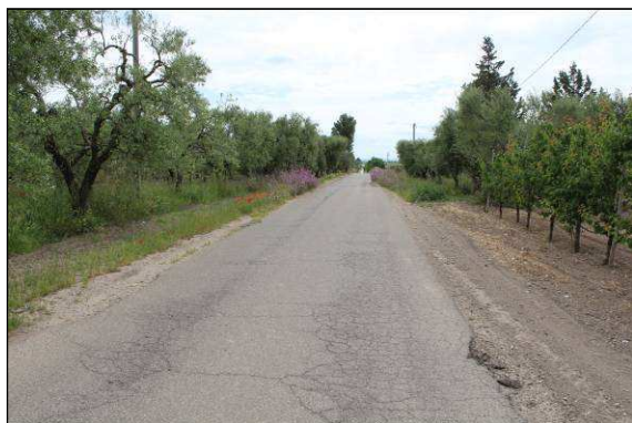
50. Elettrodotto lungo la strada vicinale Schiavone, località C. D'Acuino
