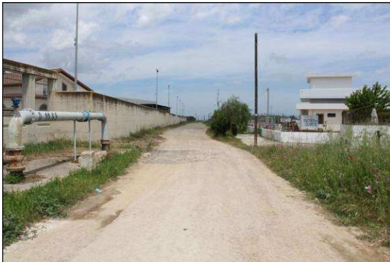
31. Accesso al parco eolico dalla viabilità di servizio della SS 16 in direzione della turbina 11, località Fontanelle
