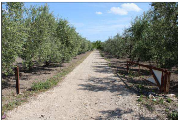
15. Elettrodotto interno da SP 72 in direzione della turbina 3, località Salice Palese
