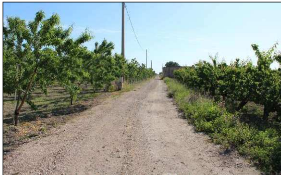
6. Elettrodotto interno da SP 72 in direzione della turbina 2, località Masseria Viro
