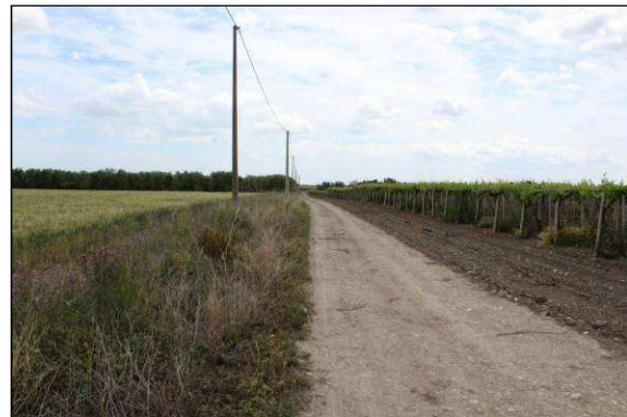
23. Elettrodotto interno dalla turbina 5 in direzione del cavidotto esterno, località Torre Giulia
