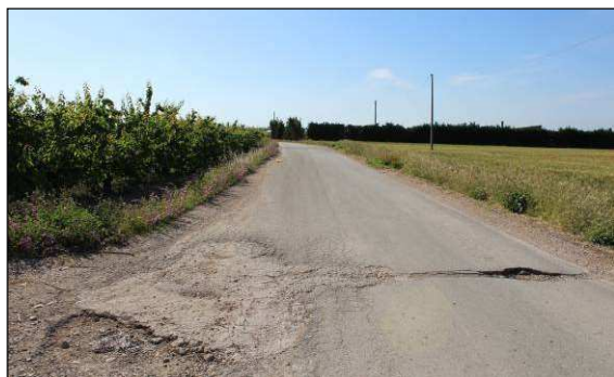
5. Elettrodotto lungo la SP 72, località Masseria Viro
