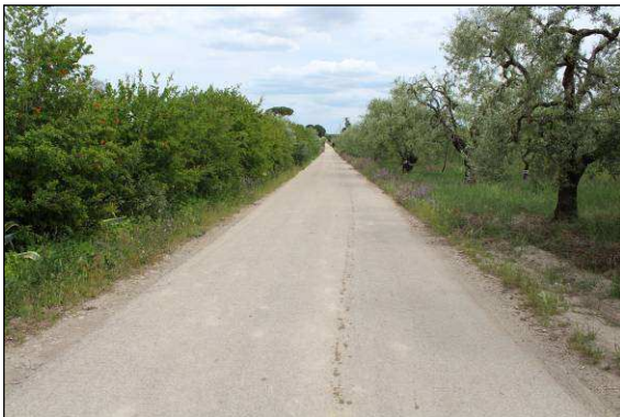
48. Elettrodotta lungo la strada comunale Contessa, località C. D'Acuino
