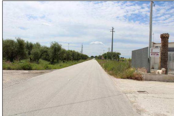
41. Elettrodotto lungo la SP 88, località Mass. la Contessa
