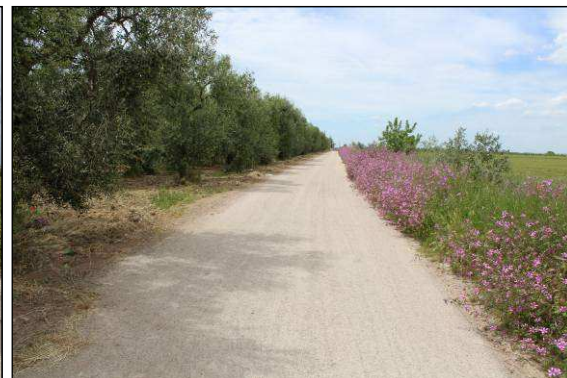
43. Elettrodotto lungo la strada comunale Contessa, località Mass. Posticciola
