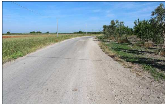
4. Elettrodotto lungo la SP 72, località Masseria Viro
