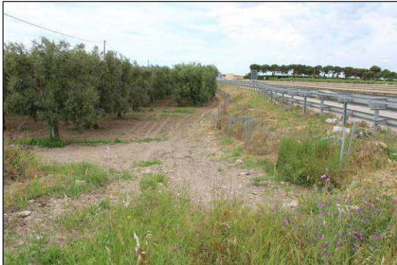
40. Elettrodotto lungo la viabilità di servizio a SW della SS 16
