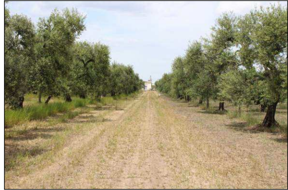
27. Elettrodotto interno in direzione della turbina 8, località Torre Giulia
