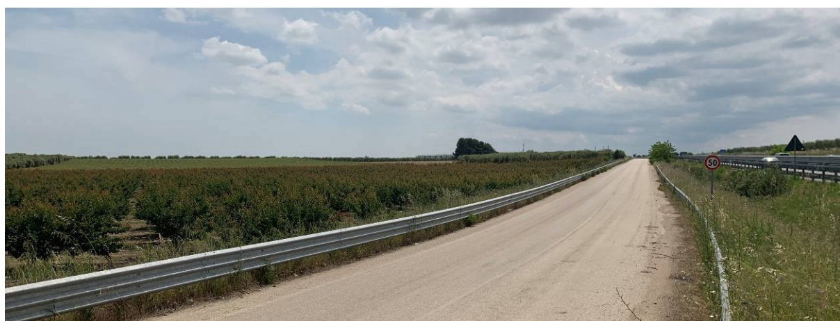
Foto S9.2: Vista della complanare della SS16, in direzione di Cerignola
