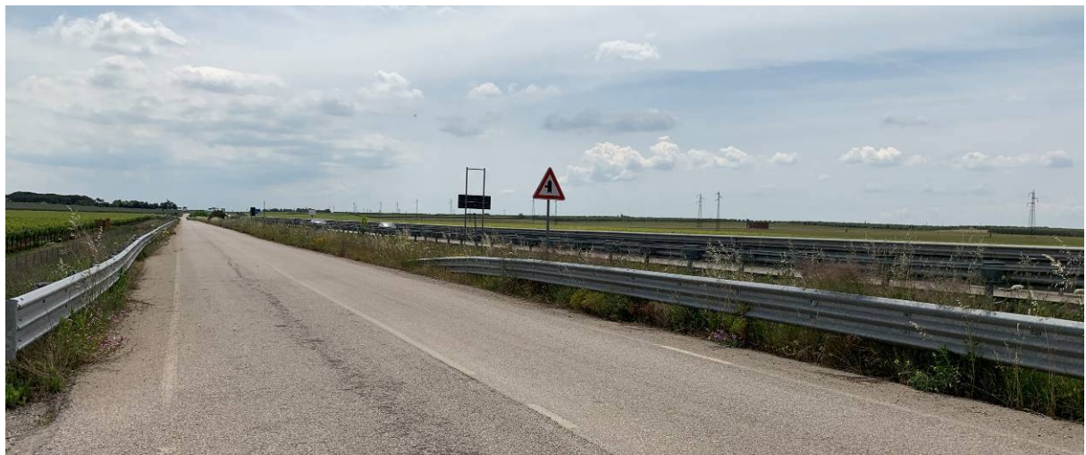
Foto S7.1: Vista della complanare della SS16, in direzione di Cerignola
