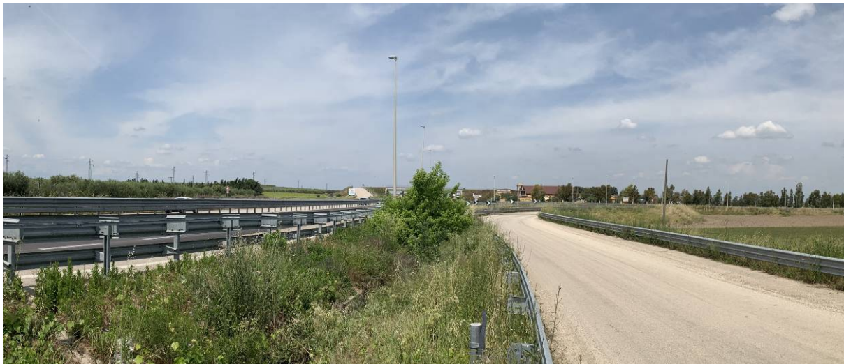
Foto S9.1: Vista della complanare della SS16, in direzione di Foggia
