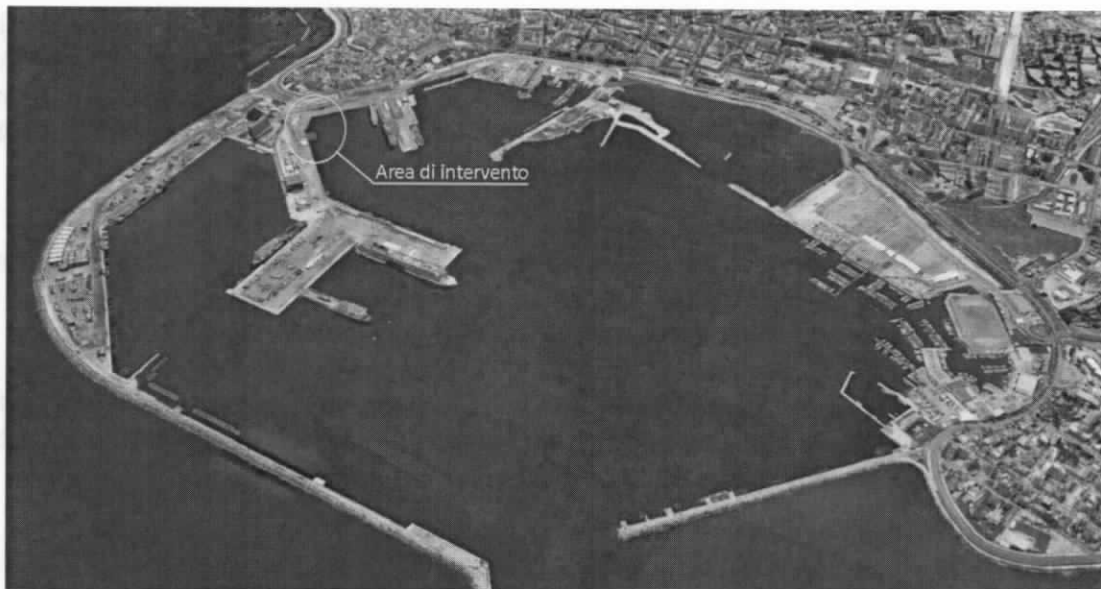
Fig. 4 – Area di intervento
