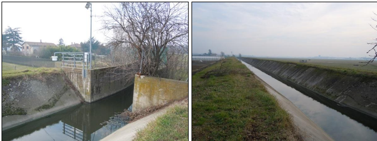
Figura 2.4 – Immagine del tratto in cui lo Scolocanocchia riemerge dopo il tombamento al di sotto dell'aeroporto (sinistra) e Immagine del suo sviluppo con rivestimento in CLS prima di Lippo di Calderara sopraelevato rispetto al piano campagna.
