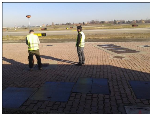
4 – Rilievo dei pozzetti sovrastanti tre collettori di diametro 100 cm e a valle le botole di un impianto di sollevamento non rilevato.
