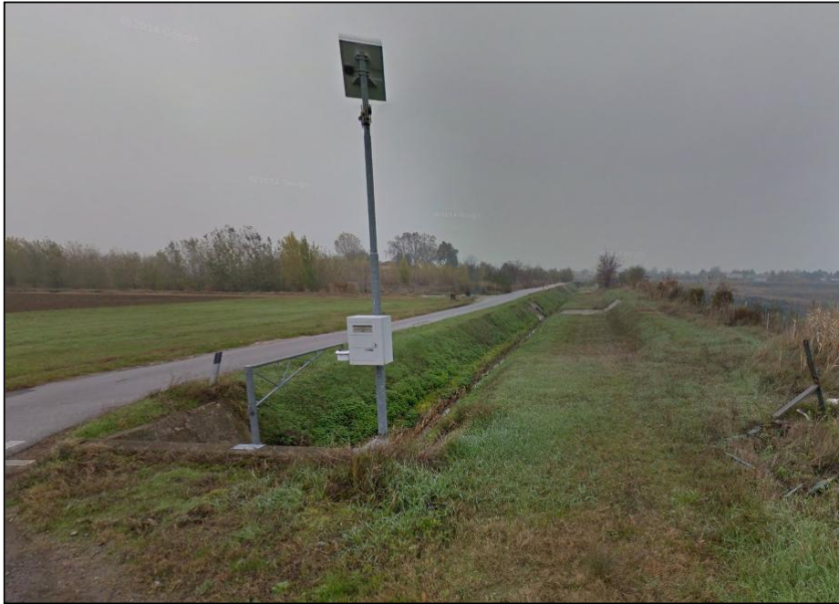
Figura 2.6 – Immagine dello Scolo Fontana con evidenziato il misuratore di livello impiegato dalla vasca di laminazione per stabilire la possibilità di sversamento all'interno dello scolo stesso.
