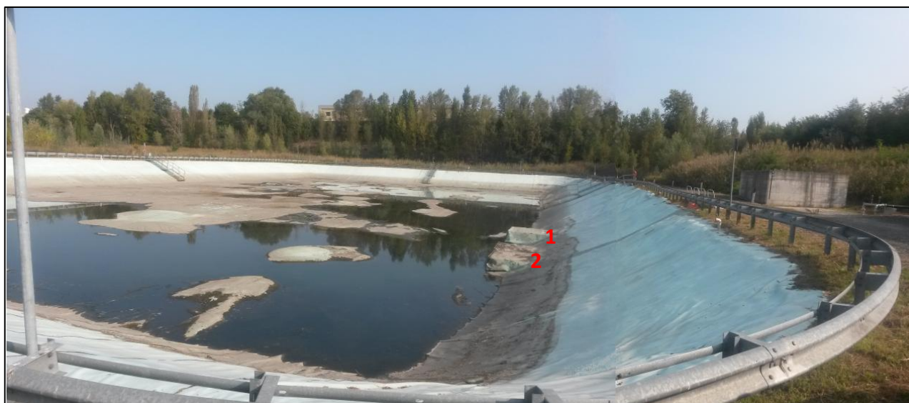
Figura 2.16 - Foto della vasca di laminazione con evidenziati il collettore di ingresso (1) e di uscita (2).
