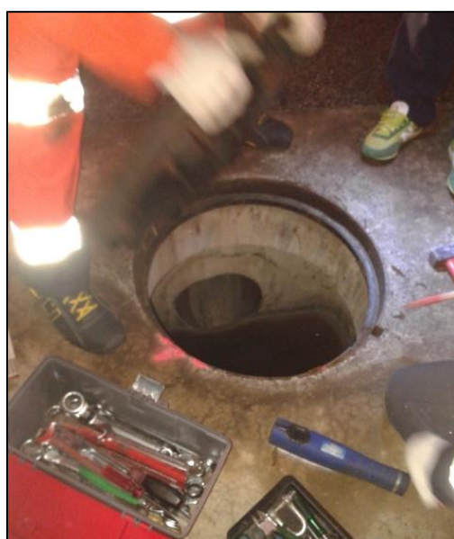
2 – Apertura di un pozzetto di confluenza tra un condotto di 40 cm e uno scolare di 30x100 cm.
