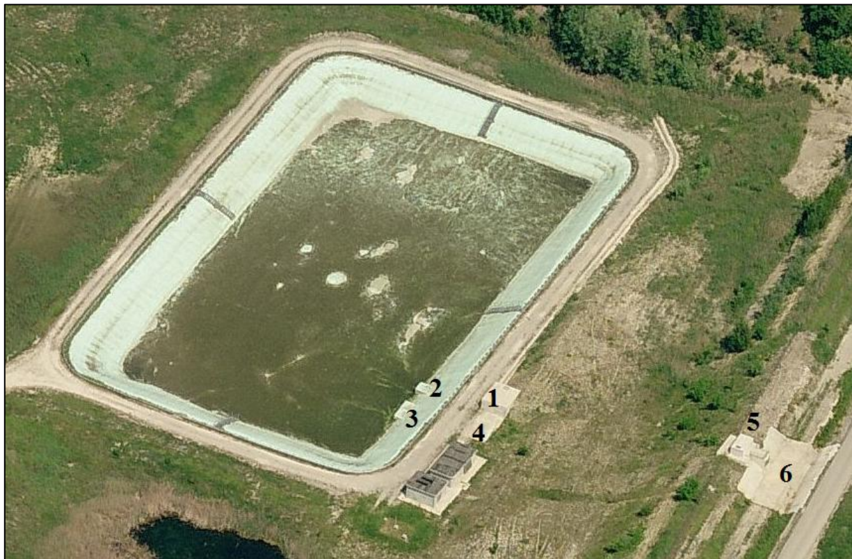
Figura 2.15 - Foto aerea della vasca di laminazione con evidenziati: la camera di ingresso (1) che mette in comunicazione la rete con la vasca; il collettore di ingresso (2); il collettore di uscita (3); la camera di pompaggio (4); camera di uscita (5) prima dello scarico nello scolo Fontana (6).
