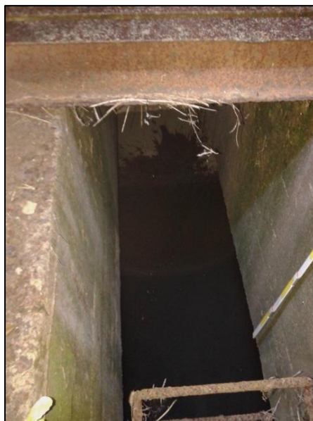
6 - La camera sottostante è lo scatolare 200x90 cm costituente il tratto a valle dei tre collettori di 100 cm posti in parallelo.
