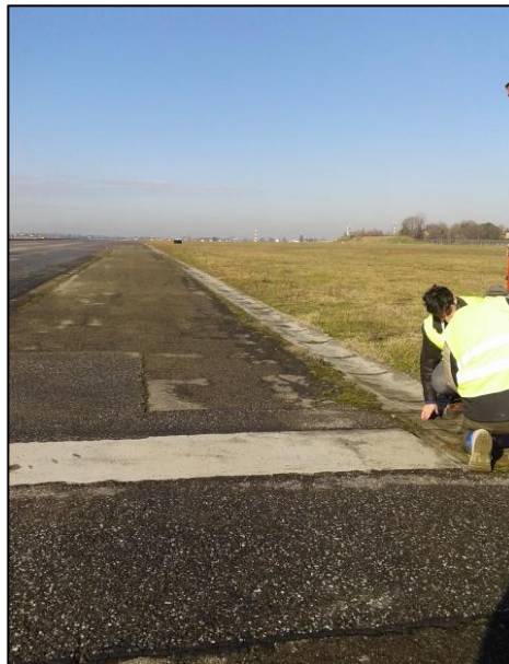
8 - Rilievo della profondità del tratto terminale delle griglie di bordo pista (lato sud-est).
