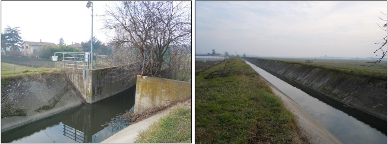
Figura 2.4 – Immagine del tratto in cui lo Scolocanocchia riemerge dopo il tombamento al di sotto dell'aeroporto (sinistra) e Immagine del suo sviluppo con rivestimento in CLS prima di Lippo di Calderara sopraelevato rispetto al piano campagna.
