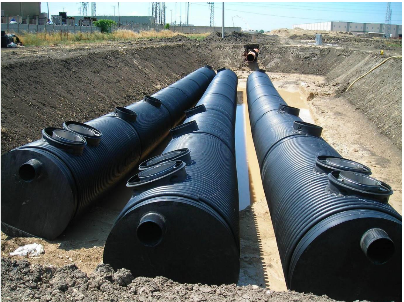
Figure 1 – Esempio di serbatoi di accumulo in HDPE con profilo di parete strutturato
