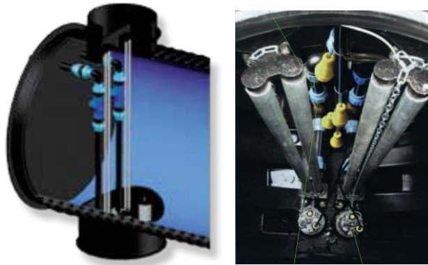
Figure 2 – Esempio di installazione di pompe su serbatoi in HDPE
