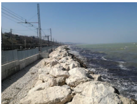
Figura 2 - Scogliera radente che costeggia il rilevato ferroviario
