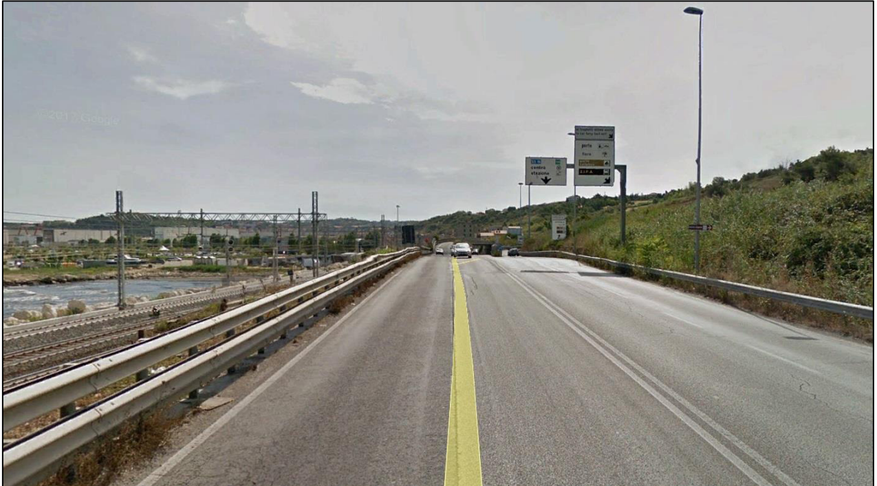
Figura 50 - Detrattore: sovrapposizione di elementi verticali (segnaletica, illuminazione, linea elettrica aerea)
