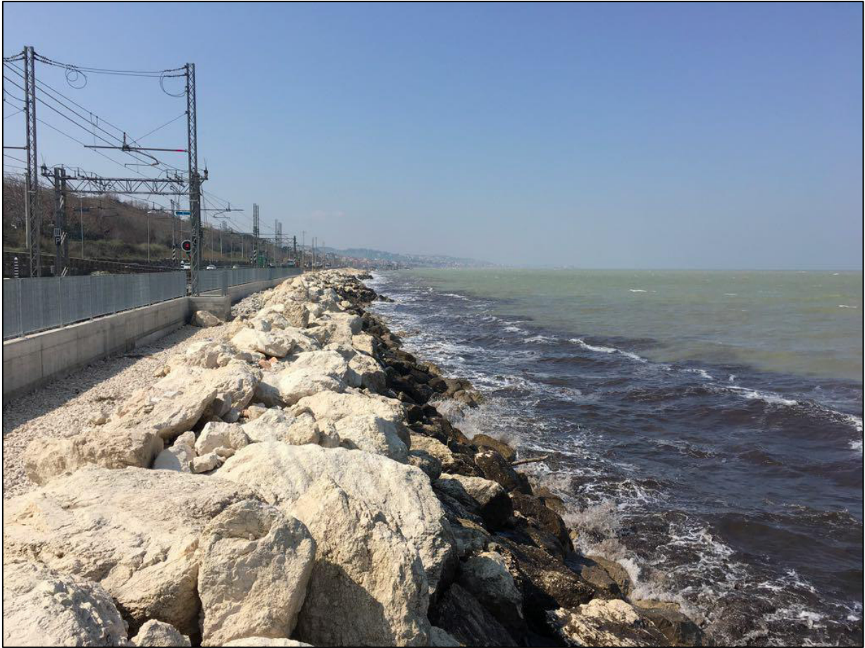
Figura 42 – Vista della scogliera a protezione della linea ferroviaria verso nord.
