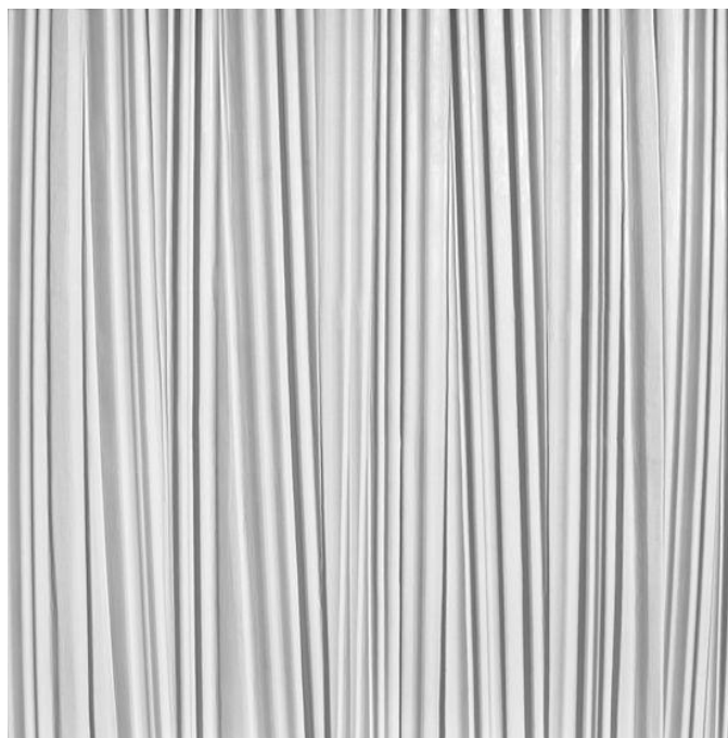
Figura 56 - Esempio di finitura su muro in cls utilizzando matrice elastica
