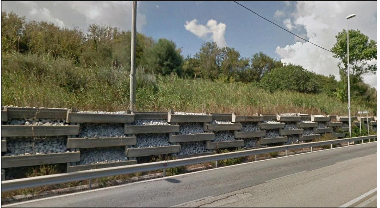
Figura 49 - Detrattore: sovrapposizione elementi orizzontali, guard rail e muri autoportanti a retta privi di vegetazione
