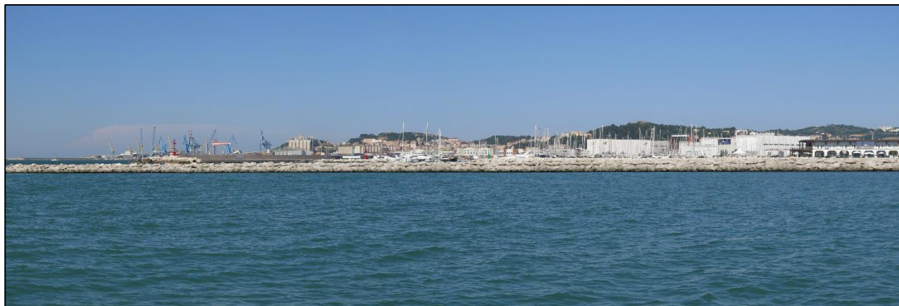
Figura 58 – Fotoinserimento 1 – Vista dal lato mare verso l’area di colmata - Stato post operam
