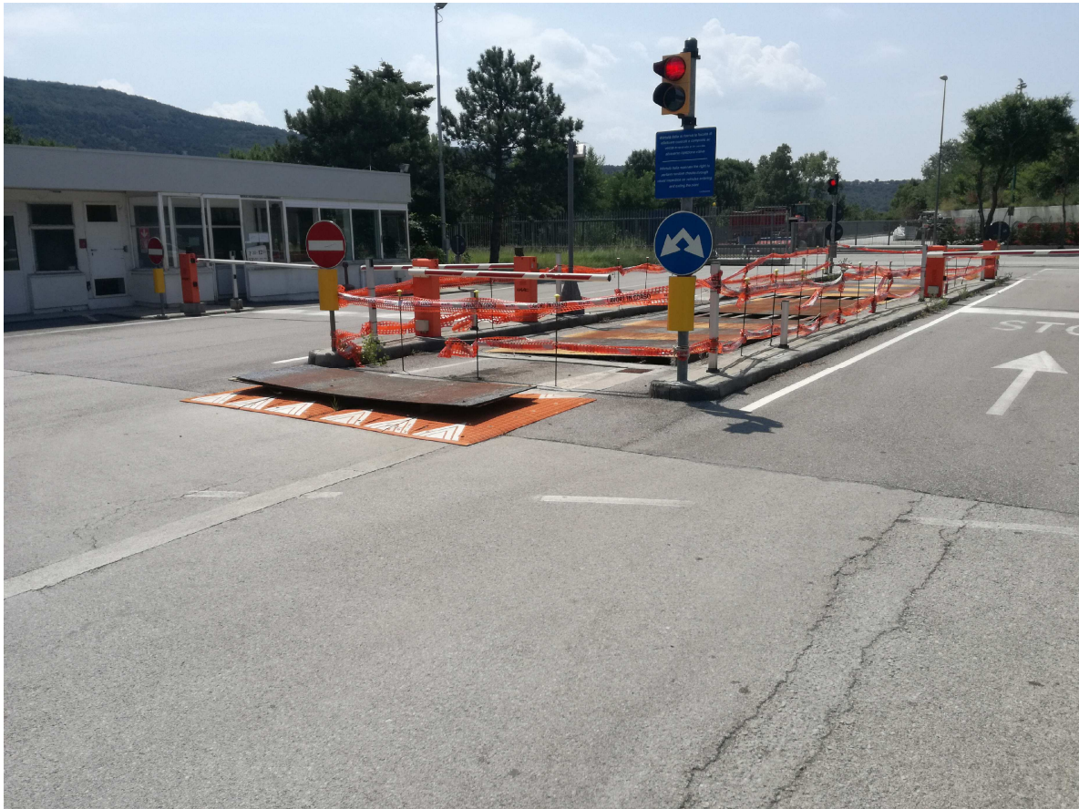
Foto 1 - Area Ingresso Carrabile
