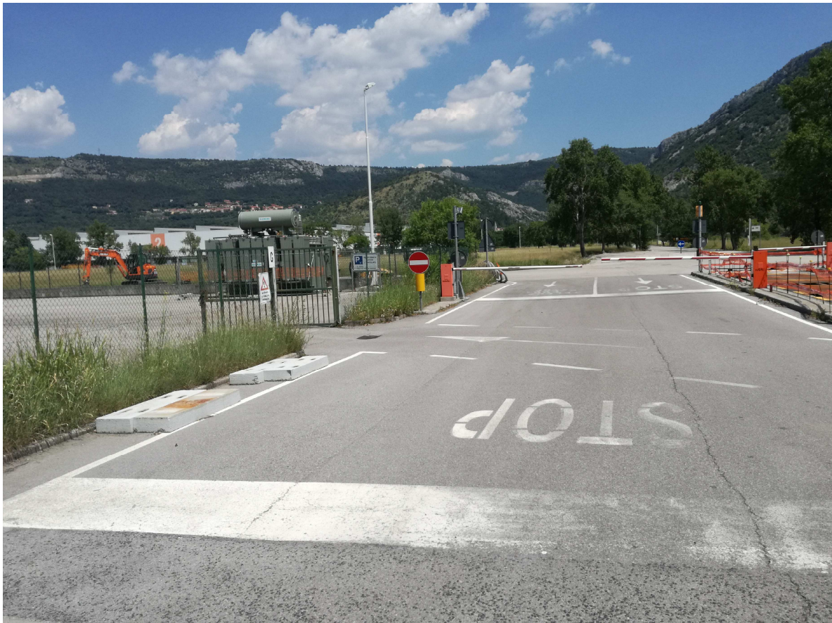
Foto 2 - Area Ingresso Carrabile
