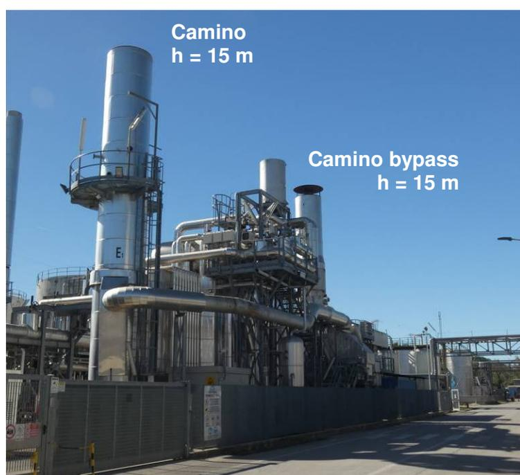
Il package turbogas, la caldaia a recupero e il relativo camino saranno posati su basamenti in calcestruzzo armato, continui e fuori terra.
