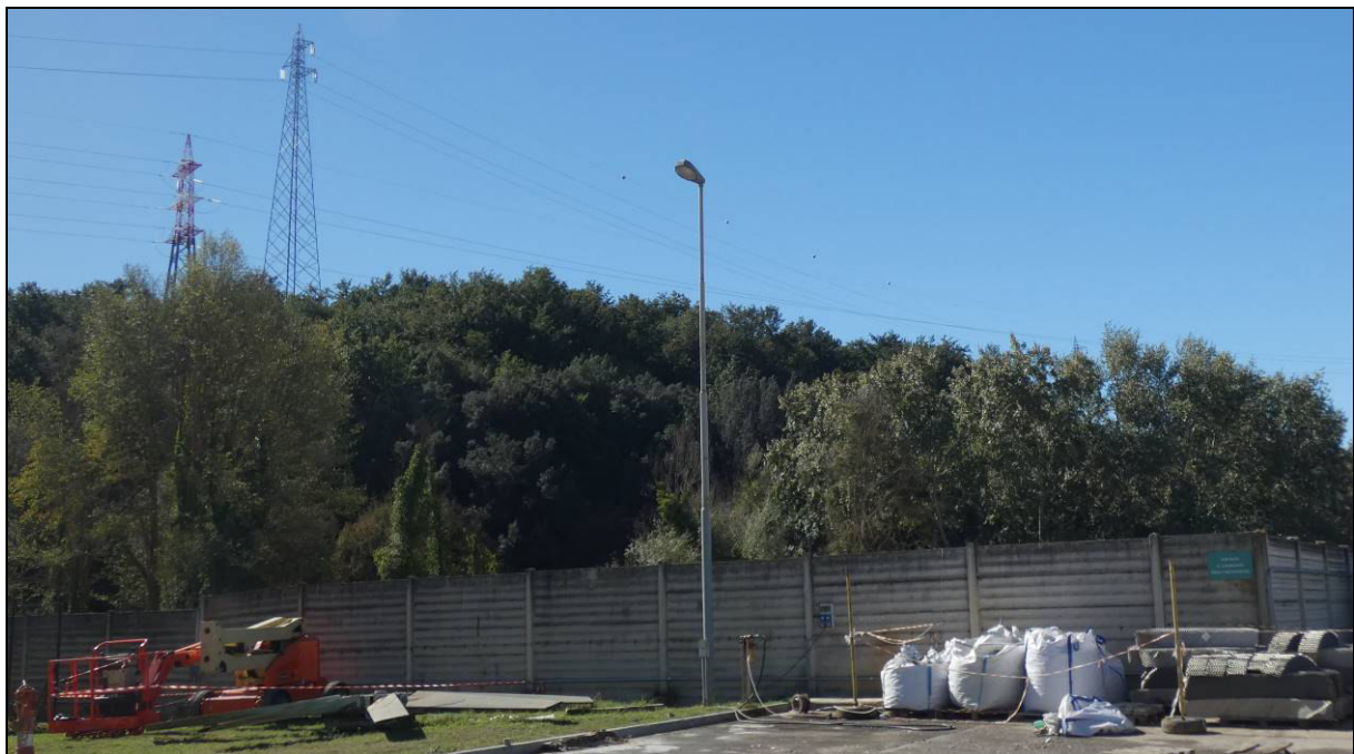
Figura 4.7/18 La fitta fascia di vegetazione boschiva a ridosso dell'area industriale Piana nelle prossimità del sito di intervento
