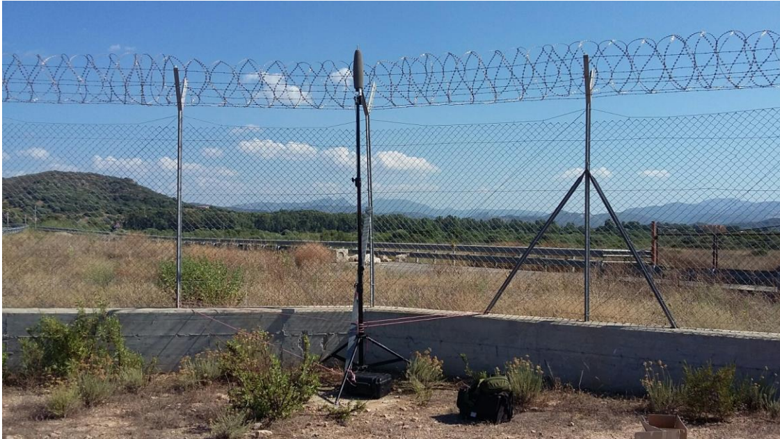
Figura 12: Cabina di monitoraggio P2405 – Testata 23
