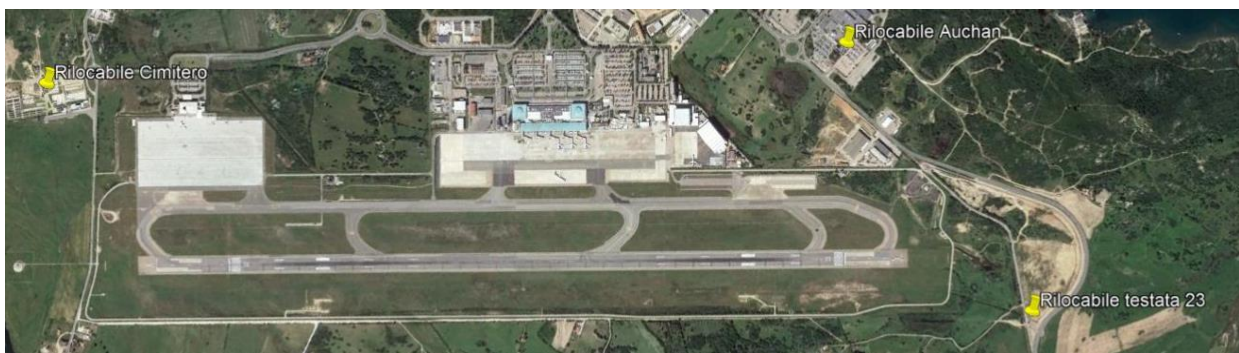
Figura 7: Ubicazione delle centraline
