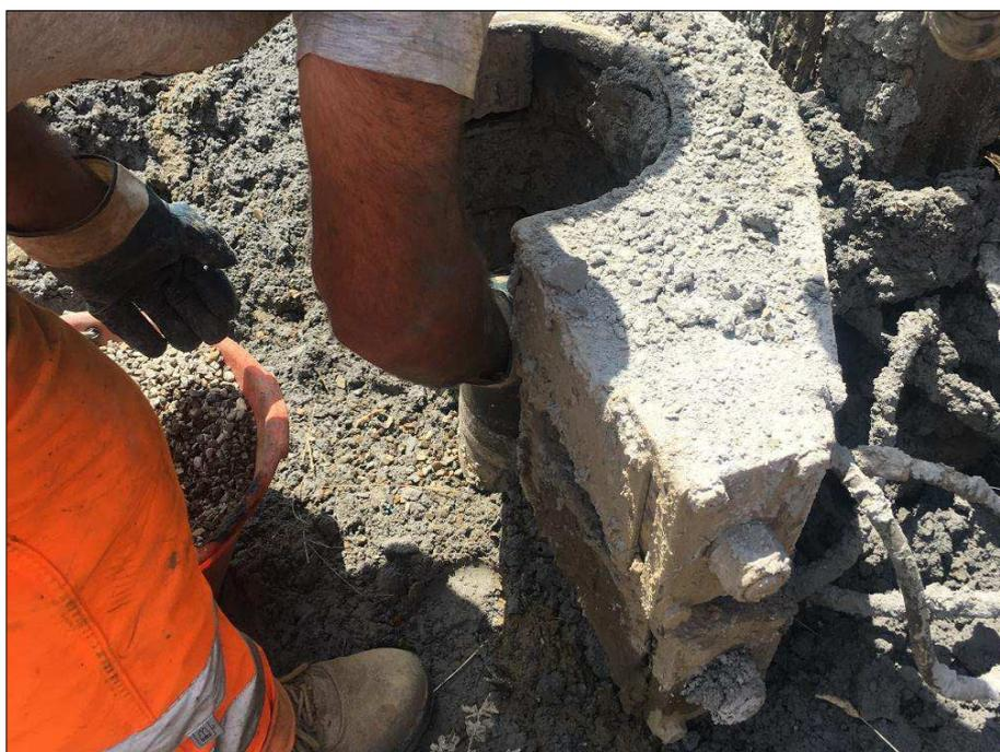
FASE DI RIEMPIMENTO FORO MEDIANTE GHIAIETTO SILICEO
