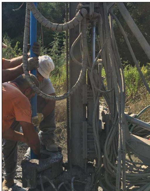
FASE DI ISTALLAZIONE DEL TUBO PIEZOMETRICO DA 2"
