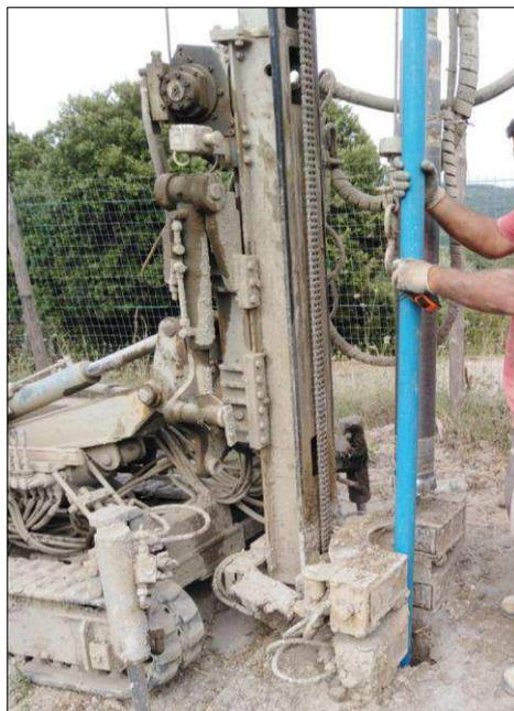
FASE DI INSTALLAZIONE DEL TUBO PIEZOMETRICO DA 2"
