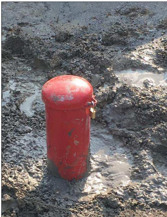
**FINE SONDAGGIO CON ISTALLAZIONE DEL CHIUSINO DI PROTEZIONE**
