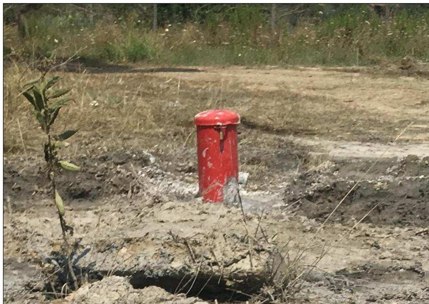
FINE SONDAGGIO CON ISTALLAZIONE DEL CHIUSINO DI PROTEZIONE
