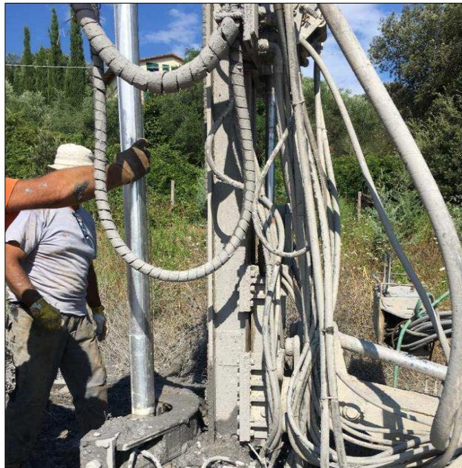
FASE DI INSTALLAZIONE DEL TUBO INCLINOMETRICO
