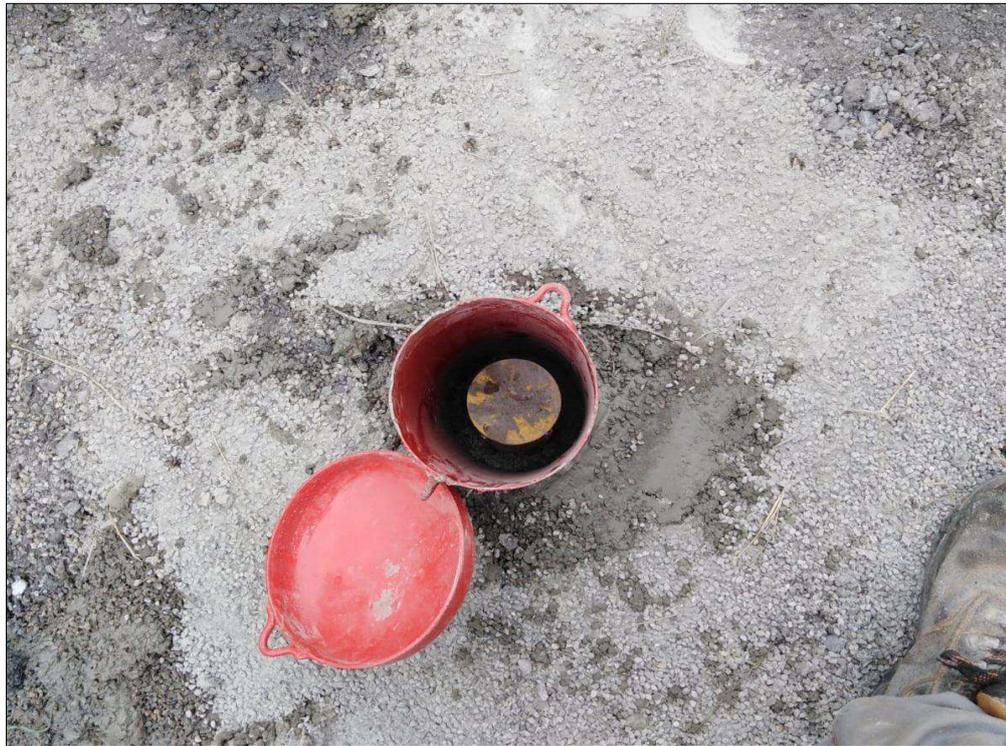
FINE SONDAGGIO CON ISTALLAZIONE DEL CHIUSINO DI PROTEZIONE
