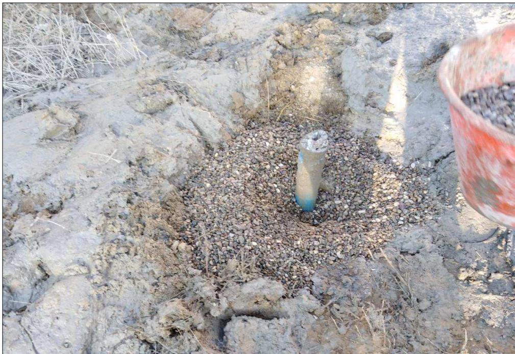
FASE DI RIEMPIMENTO FORO MEDIANTE GHIAIETTO SILICEO
