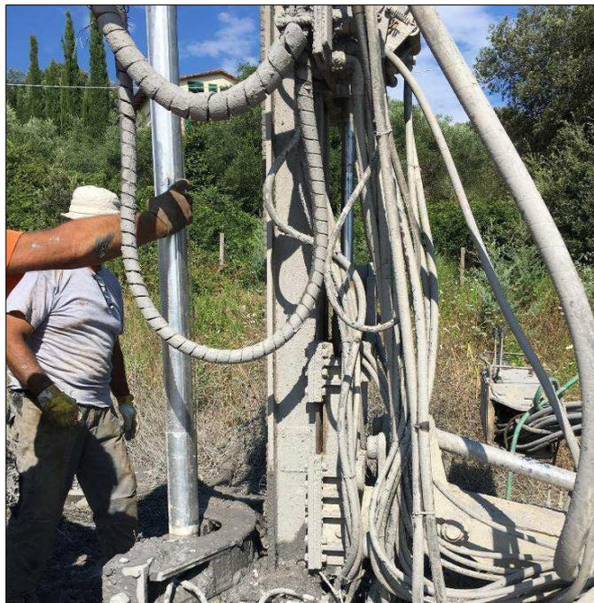
FASE DI INSTALLAZIONE DEL TUBO INCLINOMETRICO
