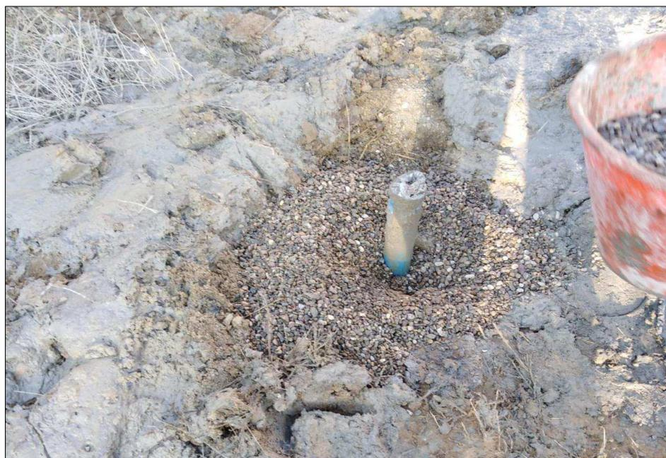
FASE DI RIEMPIMENTO FORO MEDIANTE GHIAIETTO SILICEO
