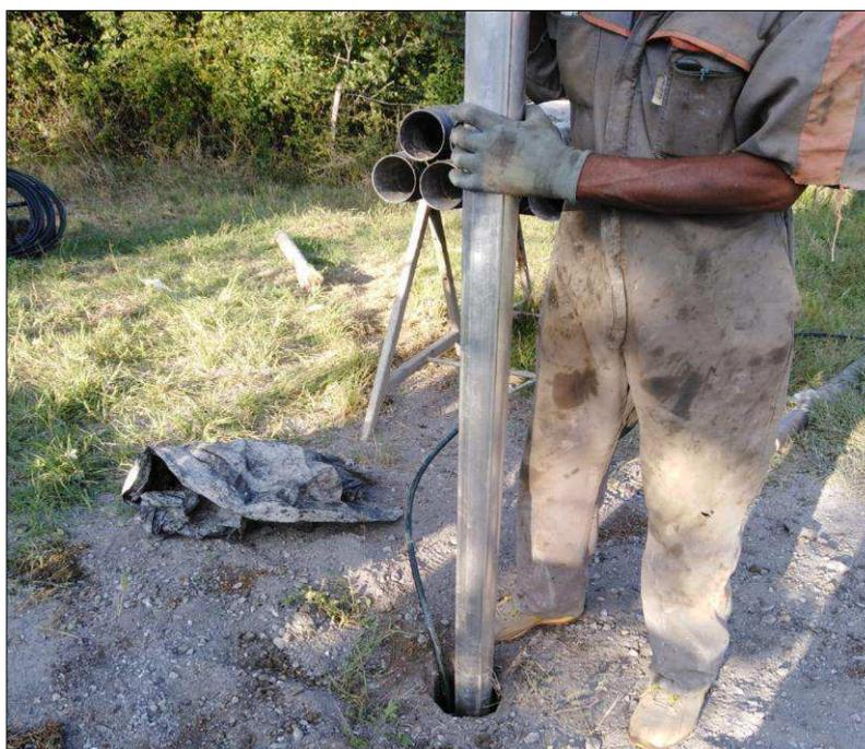
FASE DI INSTALLAZIONE DEL TUBO INCLINOMETRICO
