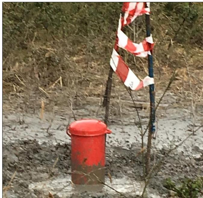
FINE SONDAGGIO CON ISTALLAZIONE DEL CHIUSINO DI PROTEZIONE
