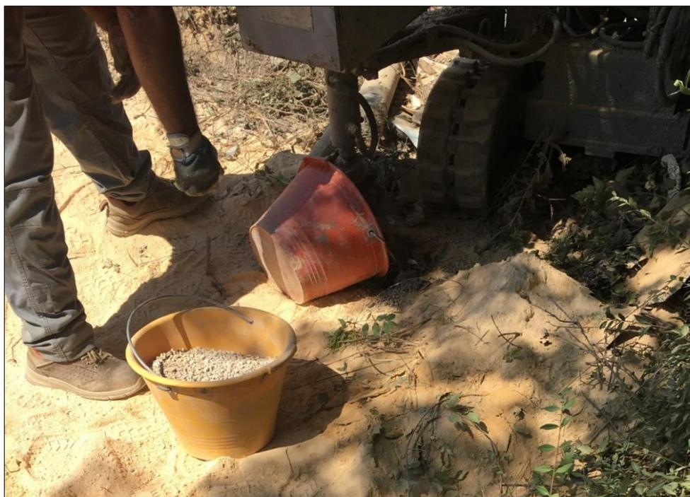
FASE DI RIEMPIMENTO FORO MEDIANTE GHIAIETTO SILICEO
