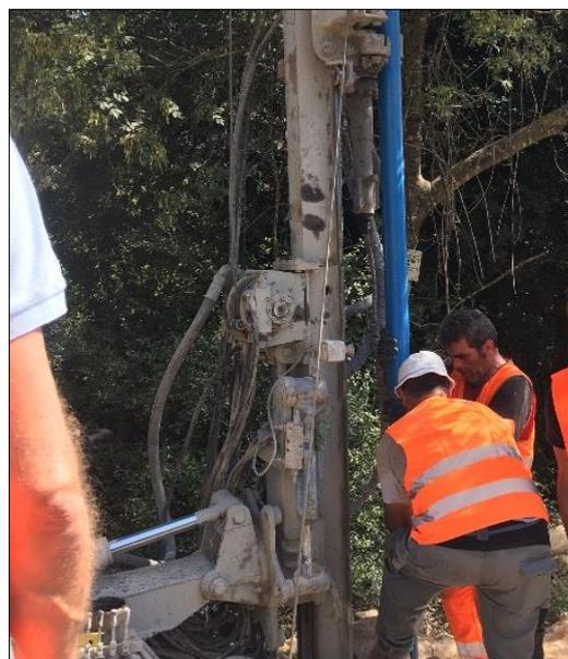
FASE DI ISTALLAZIONE DEL TUBO PIEZOMETRICO DA 3"
