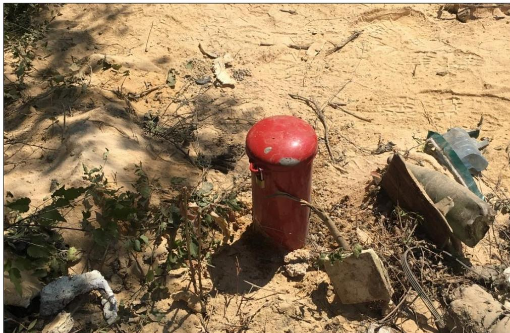
FINE SONDAGGIO CON ISTALLAZIONE DEL CHIUSINO DI PROTEZIONE
