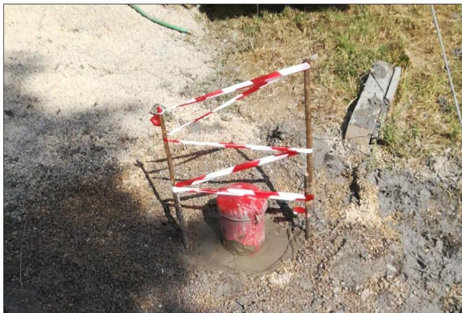
FINE SONDAGGIO CON ISTALLAZIONE DEL CHIUSINO DI PROTEZIONE
