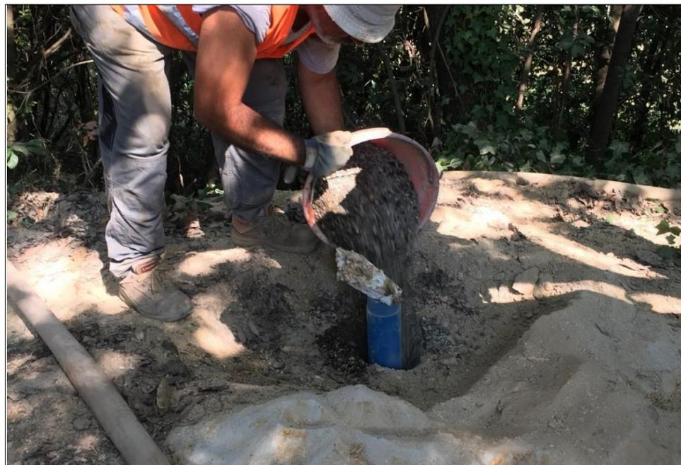
**FASE DI RIEMPIMENTO FORO MEDIANTE GHIAIETTO SILICEO**
