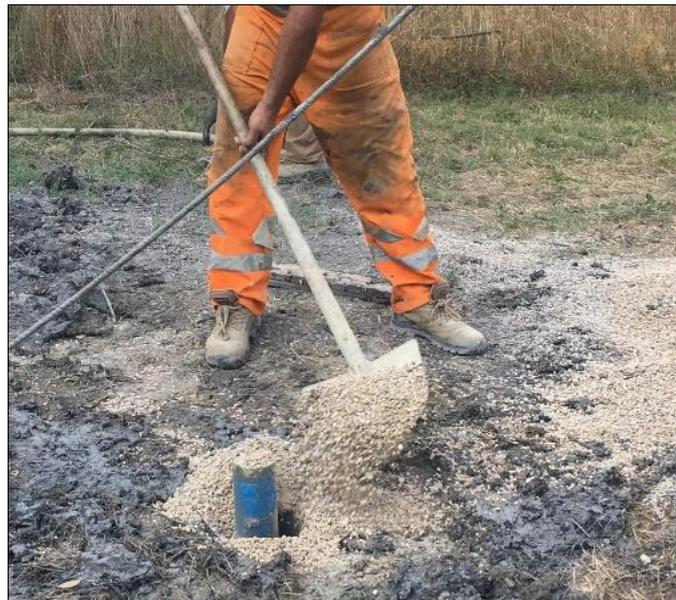
FASE DI RIEMPIMENTO FORO MEDIANTE GHIAIETTO SILICEO
