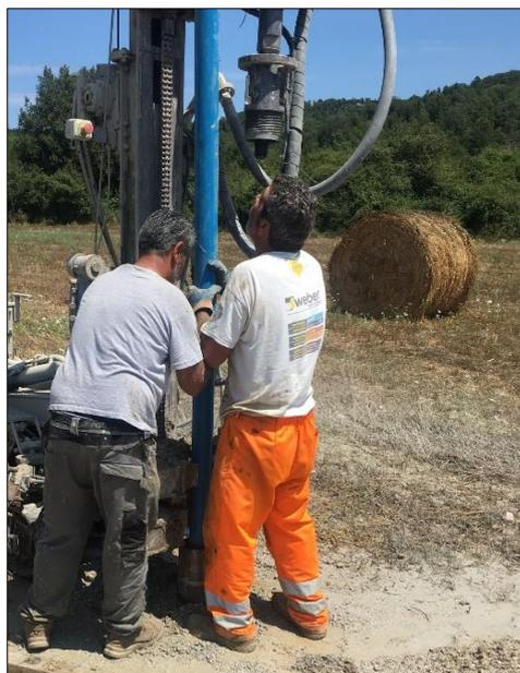
FASE DI ISTALLAZIONE DEL TUBO PIEZOMETRICO DA 3"
