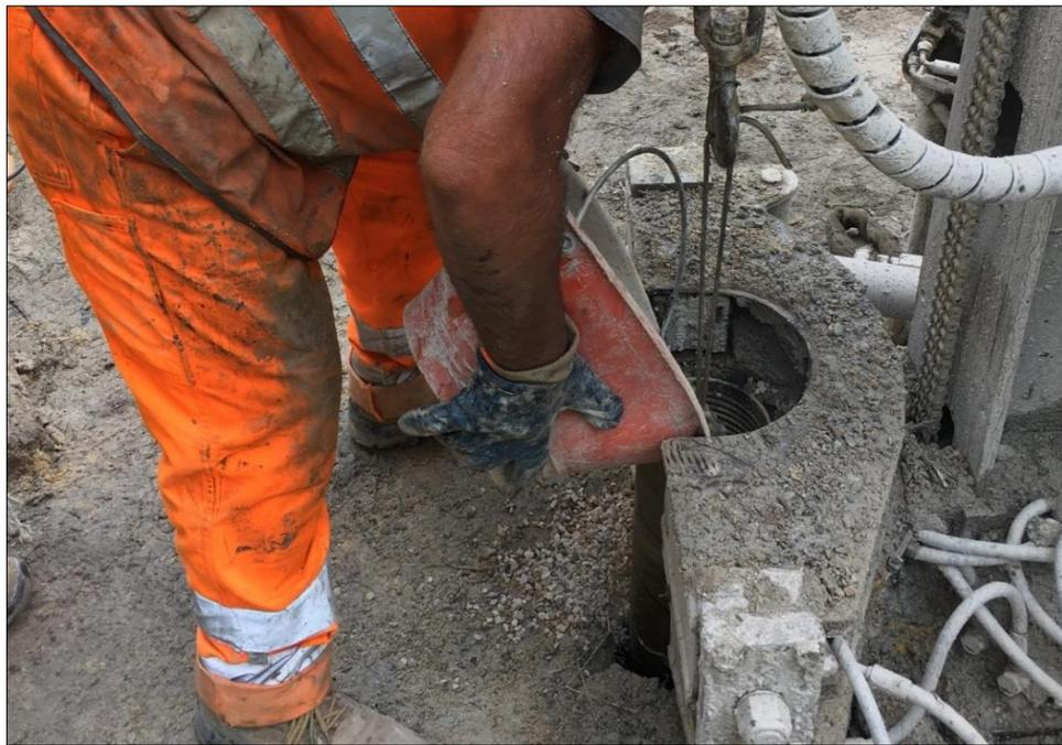
FASE DI RIEMPIMENTO FORO MEDIANTE GHIAIETTO SILICEO
