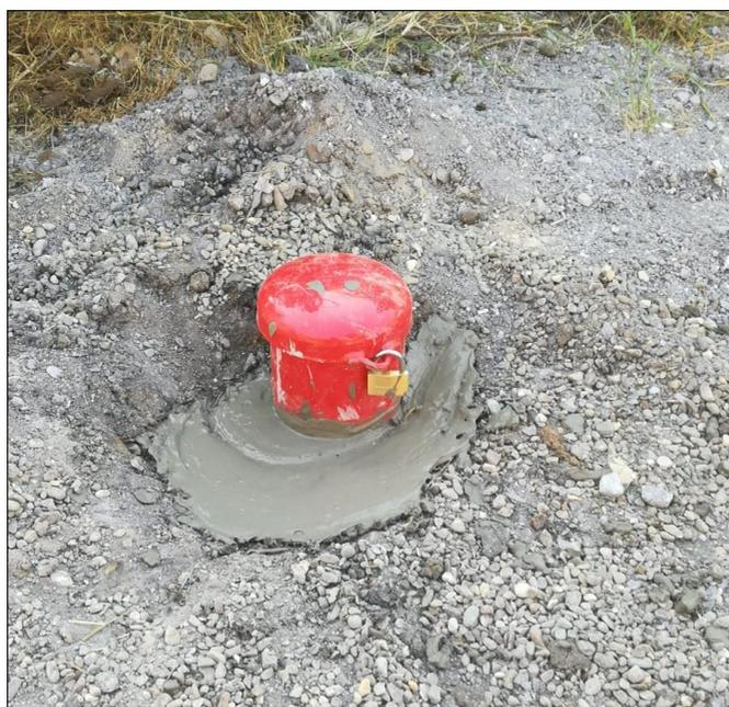
FINE SONDAGGIO CON ISTALLAZIONE DEL CHIUSINO DI PROTEZIONE
