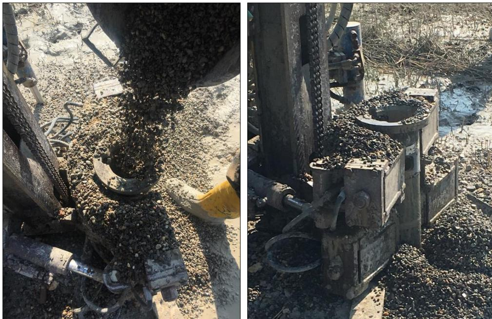
FASE DI RIEMPIMENTO FORO MEDIANTE GHIAIETTO SILICEO
