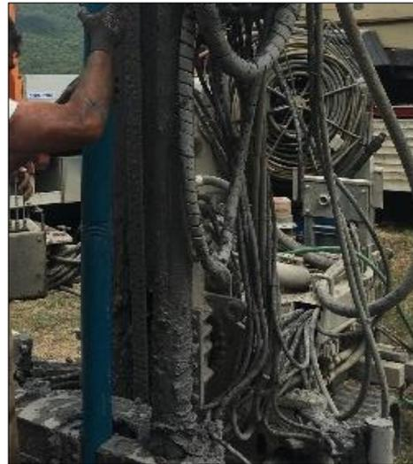
FASE DI ISTALLAZIONE DEL TUBO PIEZOMETRICO DA 3"
