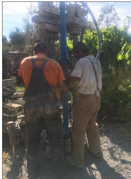
FASE DI ISTALLAZIONE DEL TUBO PIEZOMETRICO DA 3"
