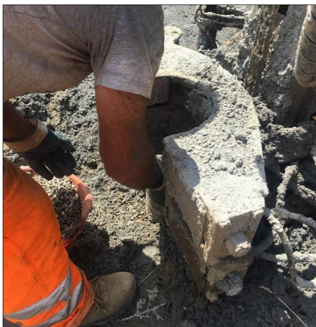
FASE DI RIEMPIMENTO FORO MEDIANTE GHIAIETTO SILICEO
