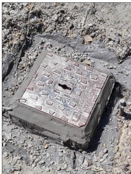
FINE SONDAGGIO CON ISTALLAZIONE DEL CHIUSINO DI PROTEZIONE
