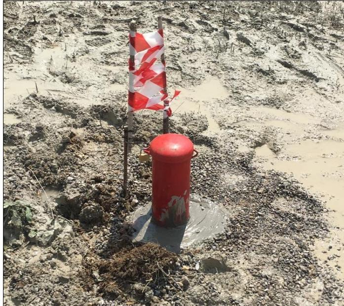
**FINE SONDAGGIO CON ISTALLAZIONE DEL CHIUSINO DI PROTEZIONE**
