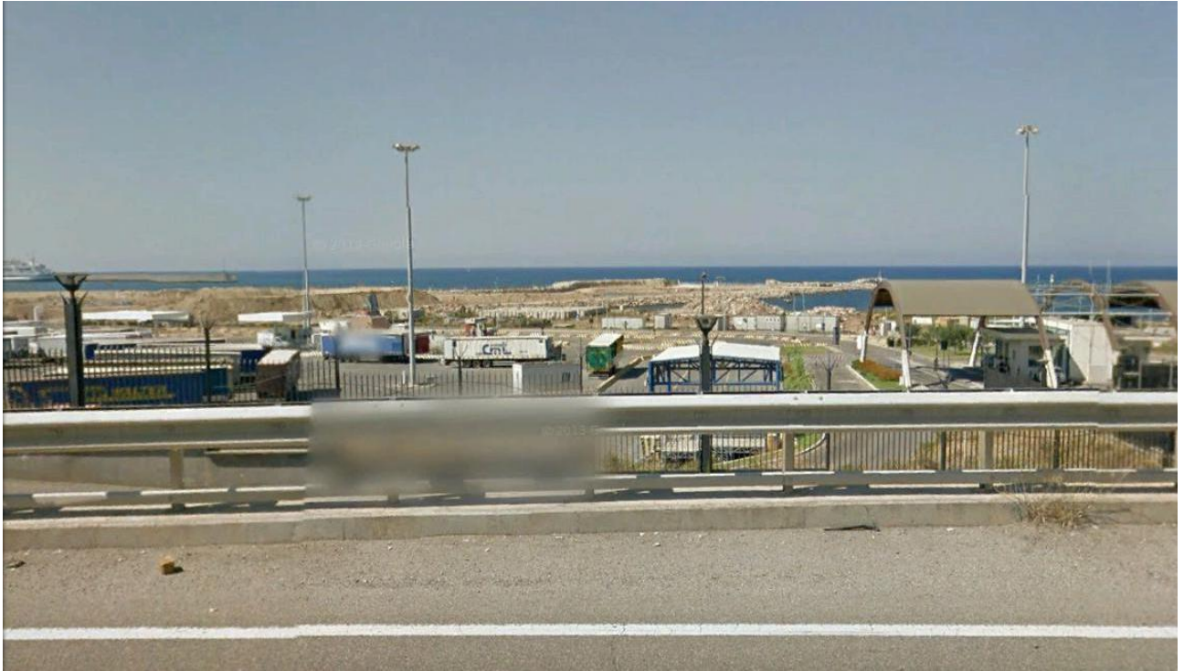
Immagini dalla S.S. Aurelia, direzione ovest, sullo sfondo l' area di cantiere.
