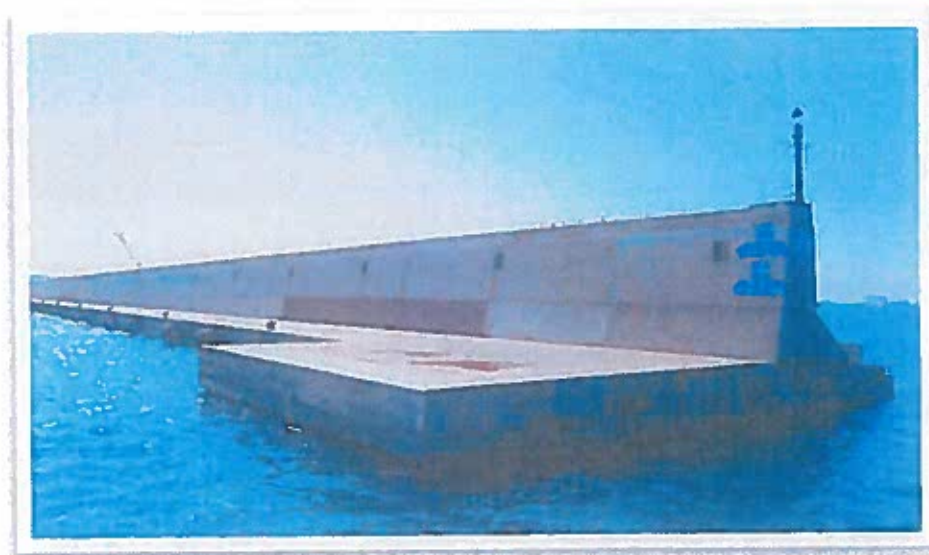
Figura 2 - Vista muro paraonde P.A.C.
