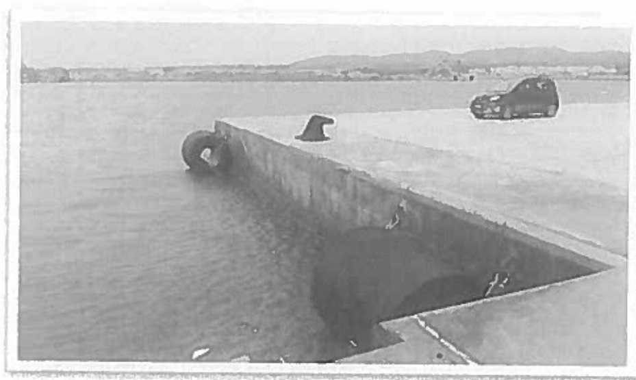
Figura 1 - Particolare fronte banchina antemurale.
