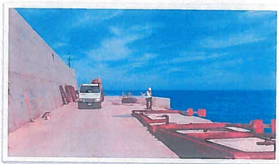
Figura 3 - Tratto terminale muro paraonde
