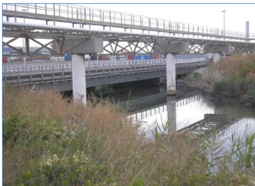
**Figura 12** - *Fosso della Fiumaretta: attraversamento aereo condotte combustibili.*
