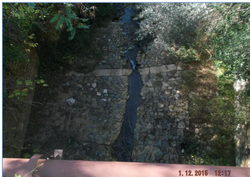
**Figura 18** - Fosso della Fiumaretta: sistemazione idraulica del fosso in corrispondenza dell'attraversamento della Via Braccianese Claudia.
