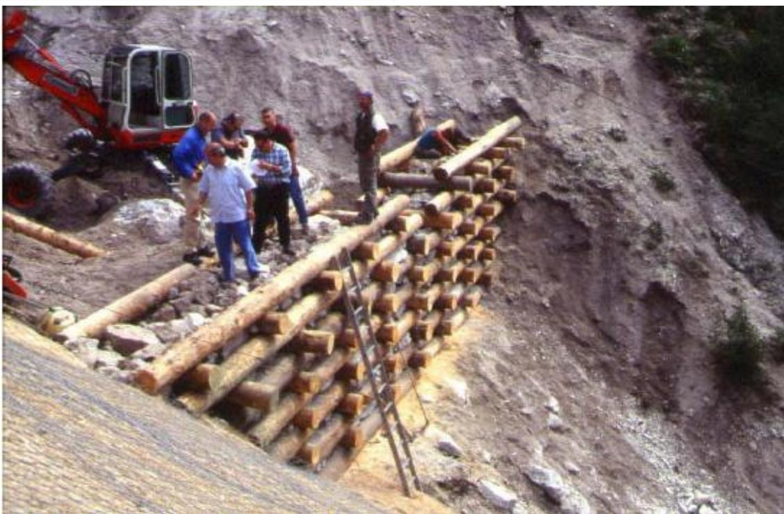
**Figura 19 -** *Interventi di ingegneria naturalistica: stabilizzazione fondo alveo con briglie in legname e pietrame rinverdito.*
