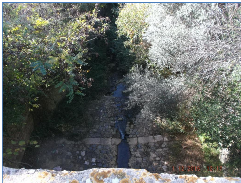
Figura 1 - Fosso della Fiumaretta: sistemazione idraulica del fosso in corrispondenza dell'attraversamento della Via Braccianese Claudia.
