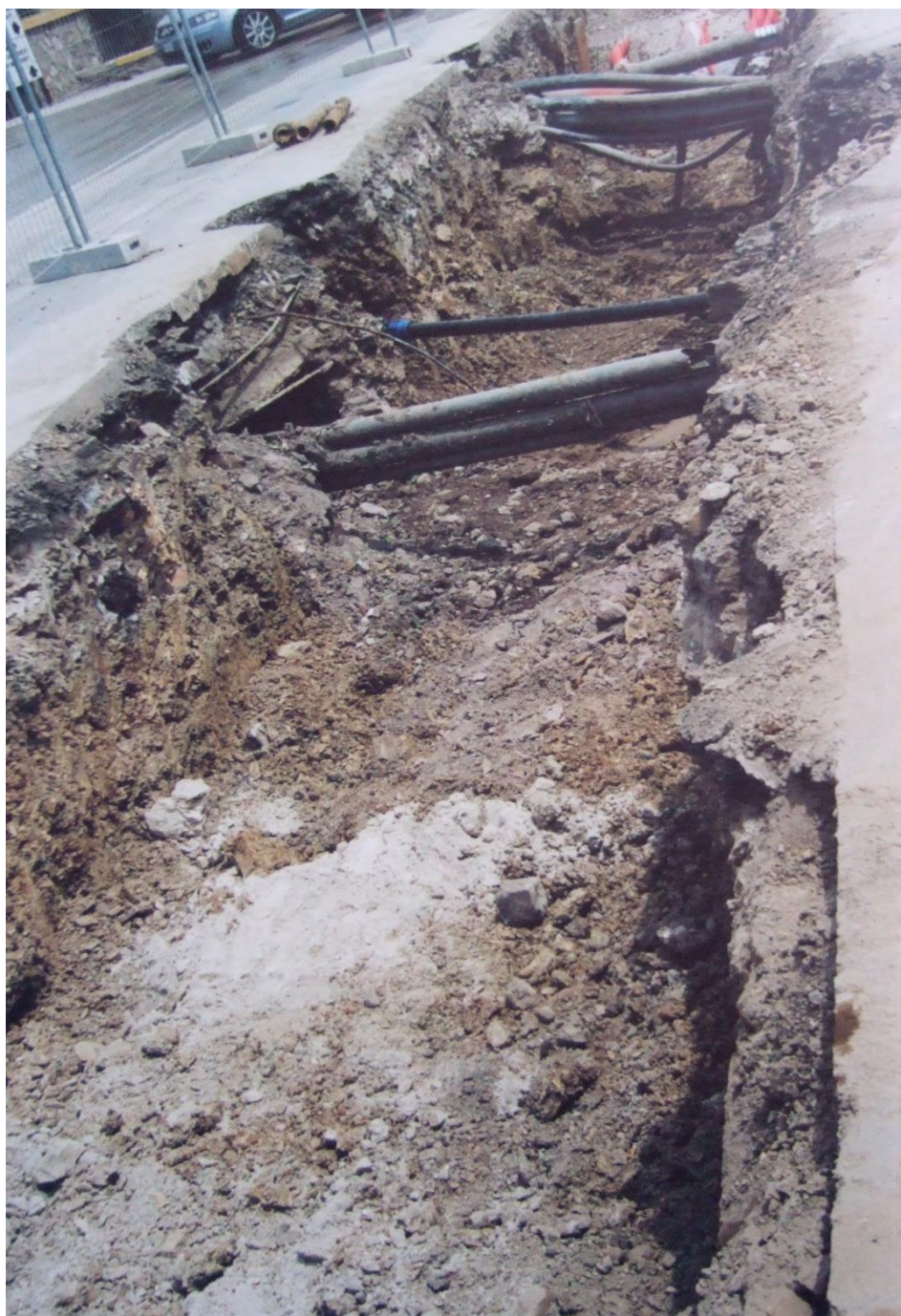
Figura 8 - Particolare della trincea scavata nel 2005-2006 per la Dorsale Reti Impiantistiche nel tratto antistante il Bar Barbagia
