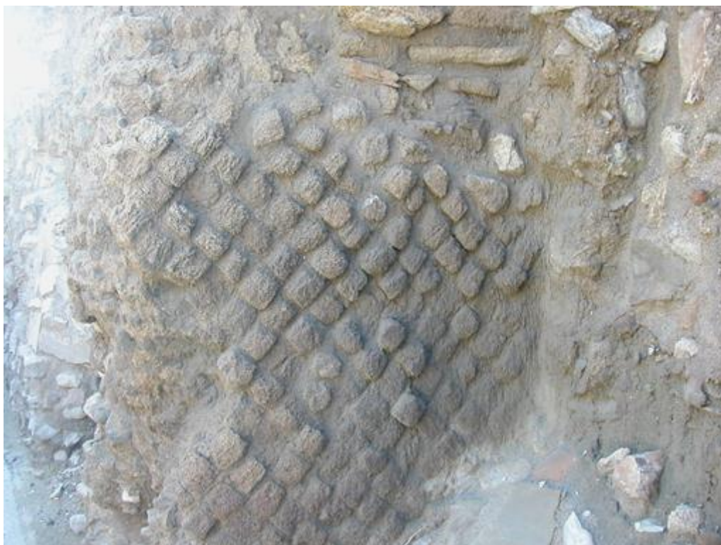
Figura 22 - Particolare della muratura in scaglia dei magazzini nel Porto, i cubilia in scaglia hanno dimensioni più o meno costanti in tutte le strutture rinvenute nel porto (ad es. al Lazzaretto), profondi 13 cm e con i lati frontali di cm 7x7
