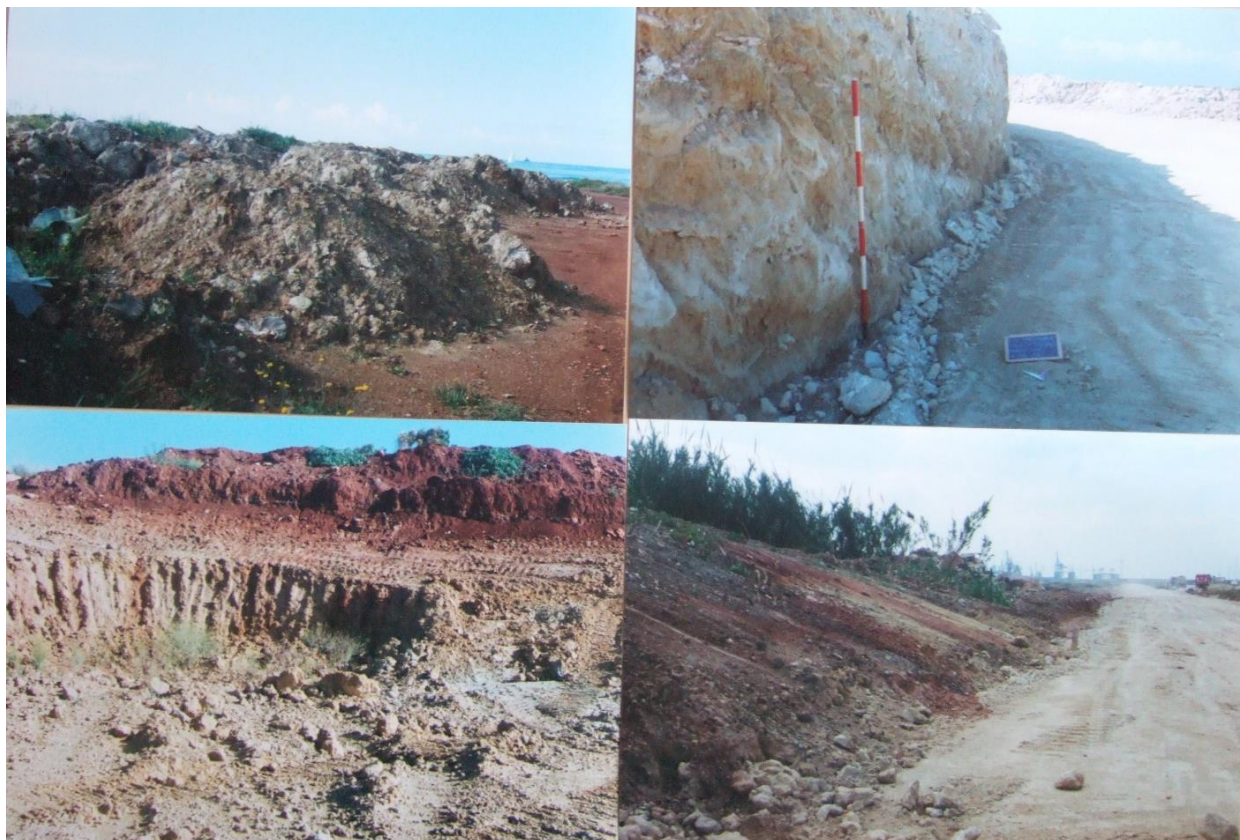
Figura 17 - Immagini che ritraggono l'operazione di sterro effettuata nel 2002 per la Viabilità Nord del Porto
