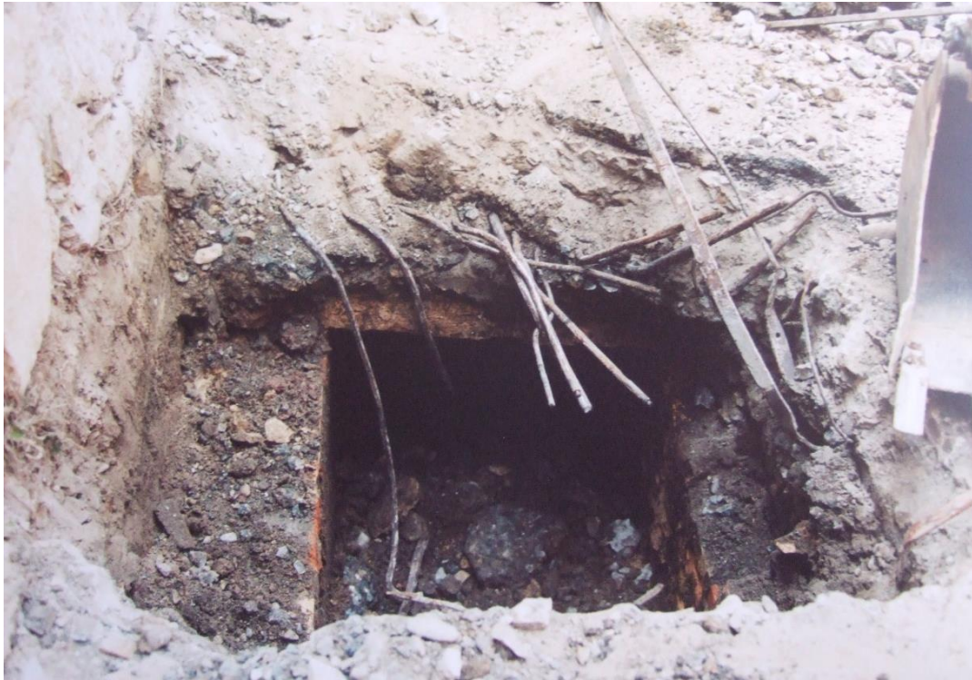
Figura 9 - Particolare di un pozzetto rinvenuto durante i lavori per la Dorsale Reti Impiantistiche nel 2005- 2006
