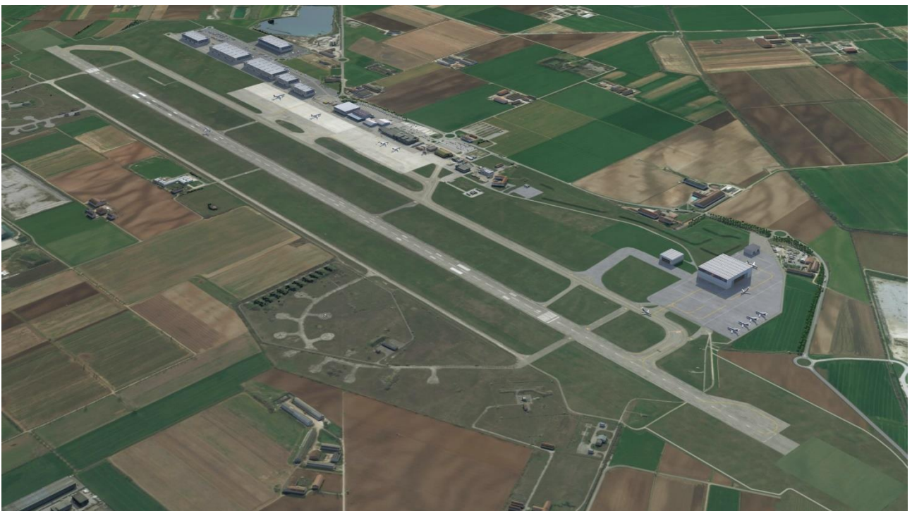
Figura 8-4 - Vista da Nord verso Sud Post operam e interventi di mitigazione
