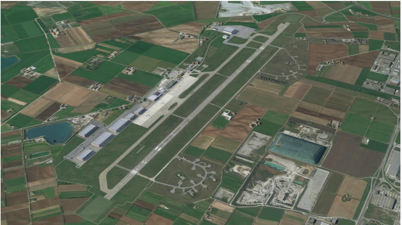
Figura 8-3 Vista da Est verso Ovest – Post operam e interventi di mitigazione
