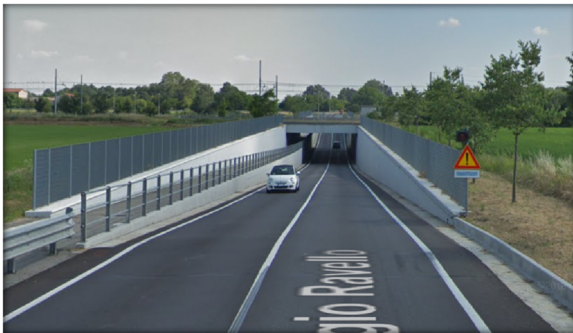
Foto 5 – Sottopasso linea ferroviaria Albairate-Vermezzo
