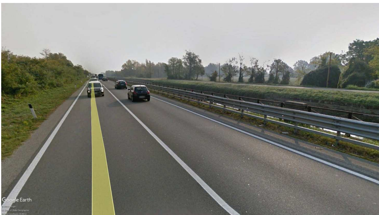
Barriera esistente (S.S.494 – fiume Naviglio Grande, attacco lato carr. Ovest)
