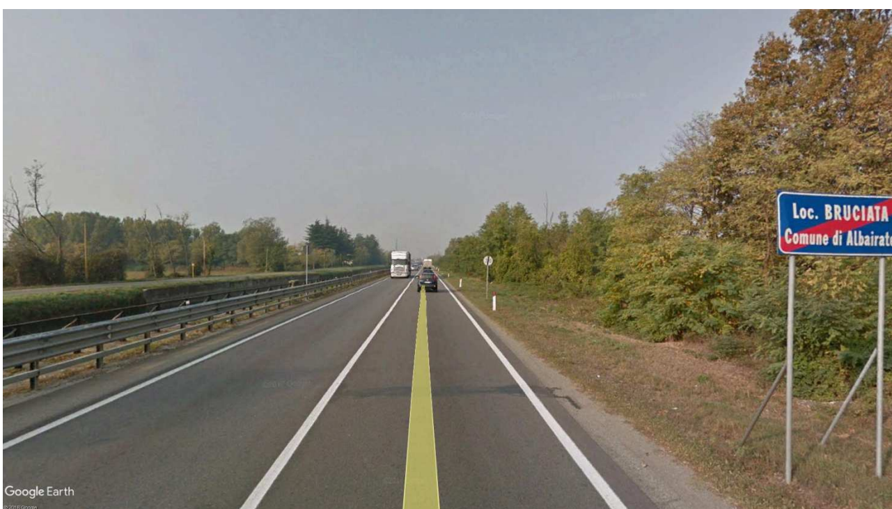
Barriera esistente (S.S.494 – fiume Naviglio Grande, attacco lato carr. Est)
