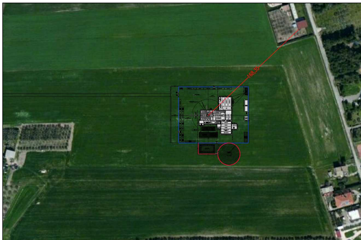
Figura 3.2: Distanza del pozzo Masseria Conca 1 Dir dal fabbricato più vicino.
