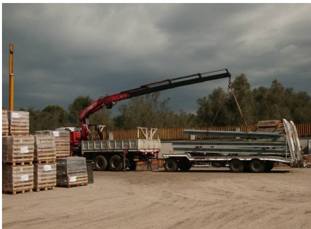
Area centrale – Carico /scarico materiale
