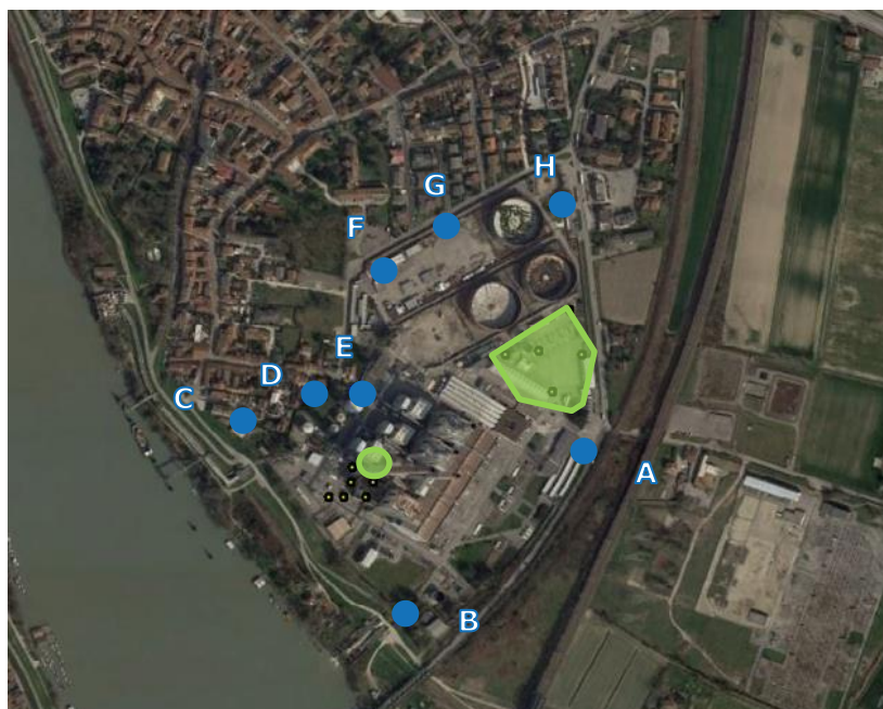
Figura 20: Recettori ed area di cantiere per la Sottofase 3B
