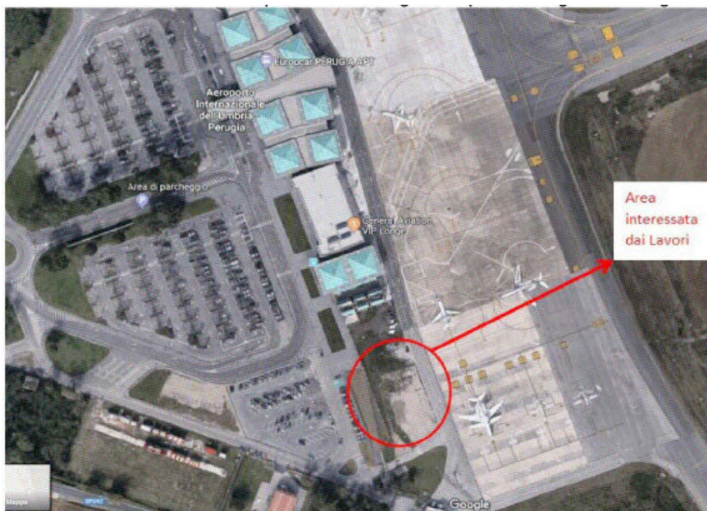
Area interessata dai lavori
