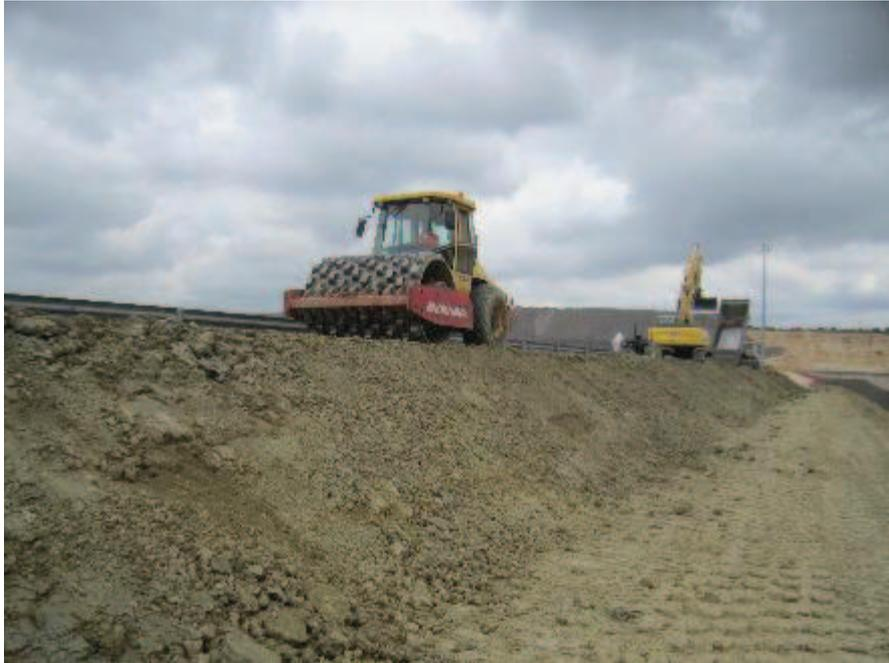
*Fotografia 8: Stesa argilla scarpata in scarpata Sud*
