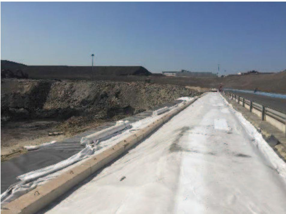
*Fotografia 11: Posa geotessile scarpata Sud*
