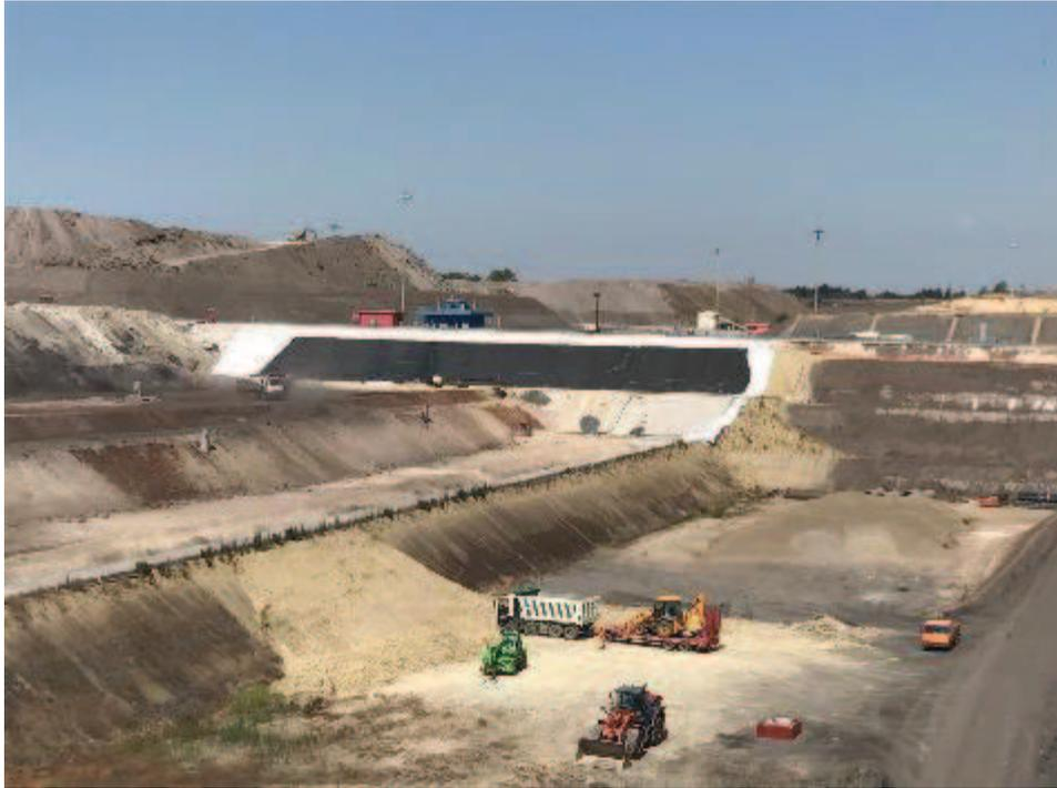
*Fotografia 10: Posa geotessile scarpata Sud*
