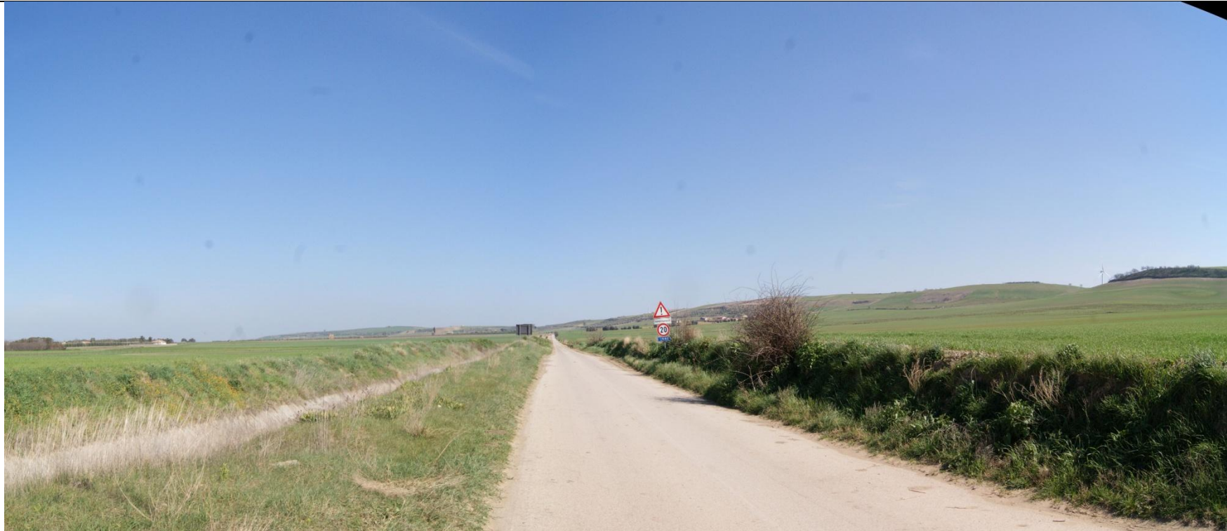
Foto 13 - Vista panoramica del gruppo di aerogeneratori WTG4 – WtG5 - WTG6 - WTG7 dall'incrocio tra le SP 52 e SP 18 verso nord
