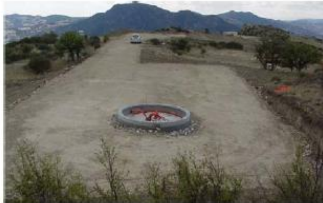
Figura 55: Fondazioni – Alloggiamento base fuori terra
