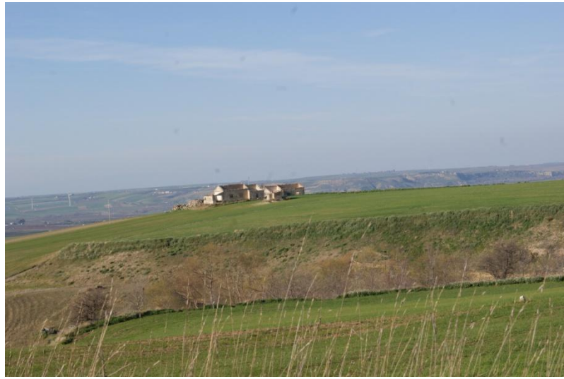
Foto 36 – Manufatti agricoli in stato di abbandono ubicati a circa 12965 m dalla WTG6(numero identificativo M35)
