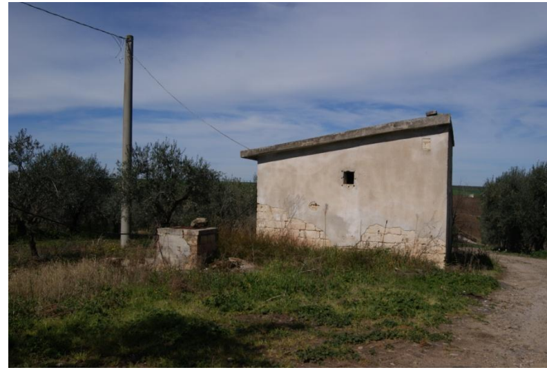
Foto 37 - Deposito attrezzi agricoli ubicato a circa 605 m dalla WTG6 (numero identificativo M30)
