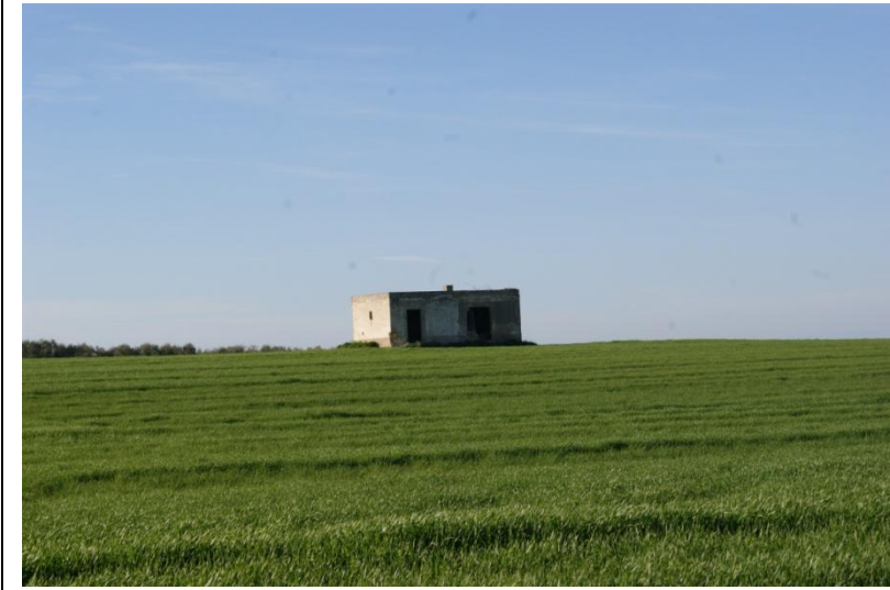
Foto 38 - Deposito attrezzi agricoli ubicato a circa 649 m dalla WTG7 (numero identificativo M37)
