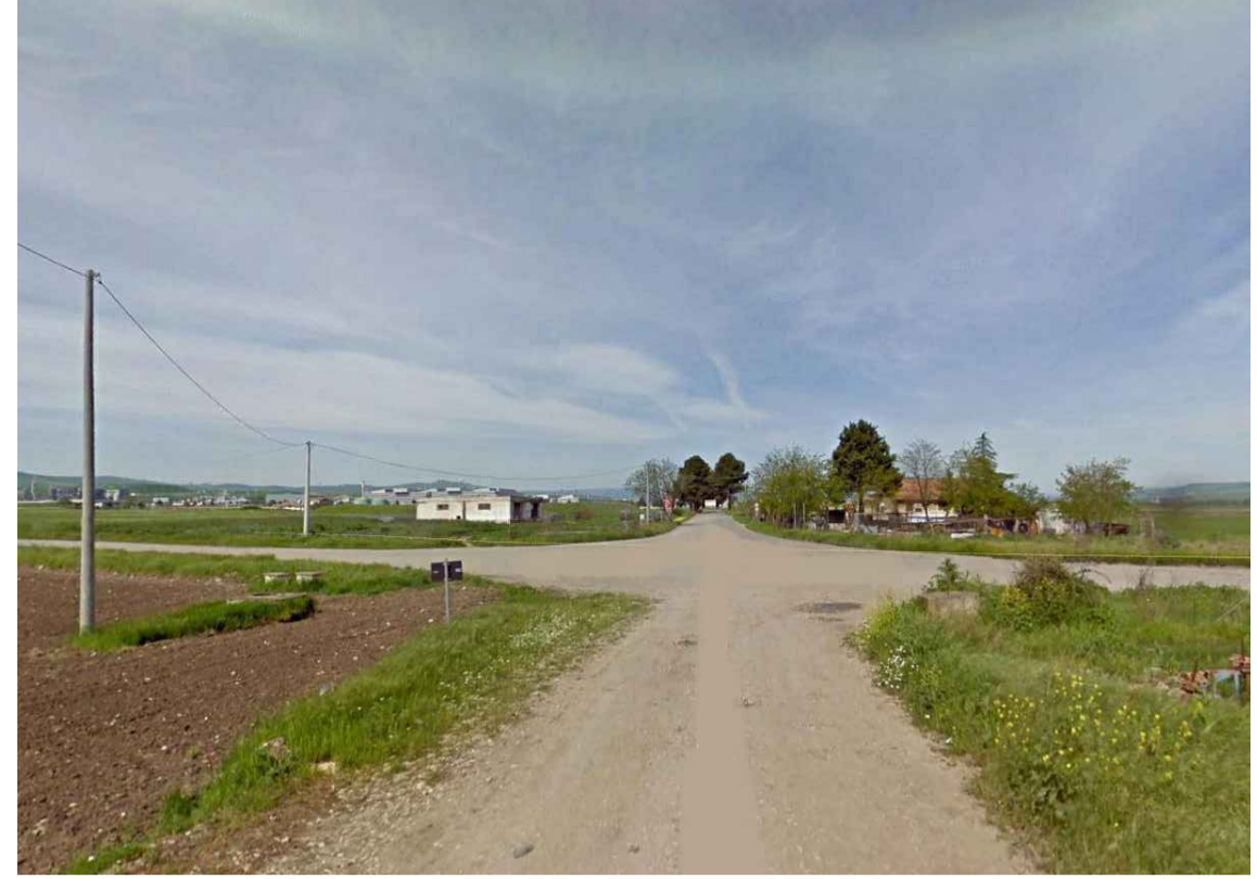
INTERSEZIONE TRA TRATTURI ASFALTATI DIVENUTI SP 94 E EP 48 BASSO MELFESE
