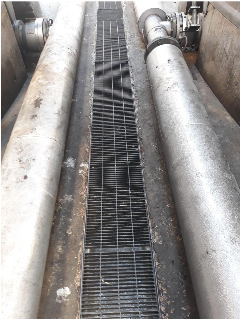
**Figura 2 - Manutenzione e pulizia Canaletta**
