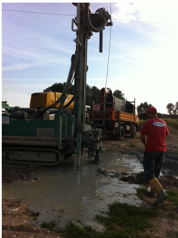
Sondaggio a carotaggio continuo eseguito dallo scrivente presso la CPR TERNA di S. Donaci nei pressi di Via Mesagne.
