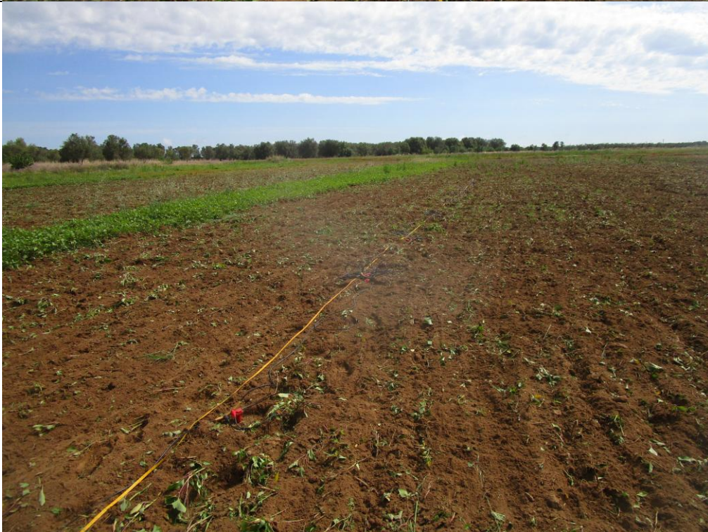
Esecuzione Masw WTG11
