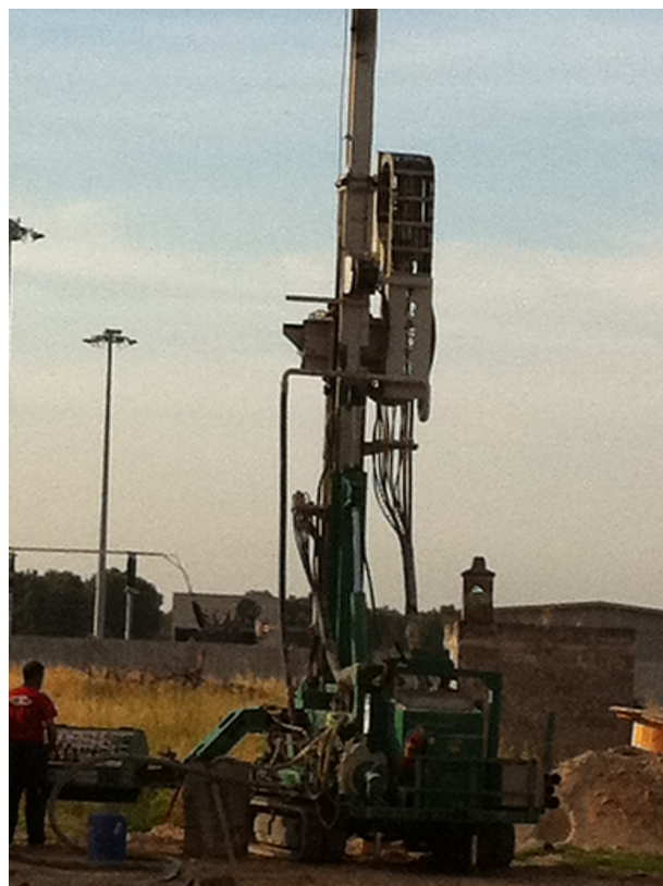
Sondaggio a carotaggio continuo eseguito dallo scrivente presso la CPR TERNA di S. Donaci nei pressi di Via Mesagne.
