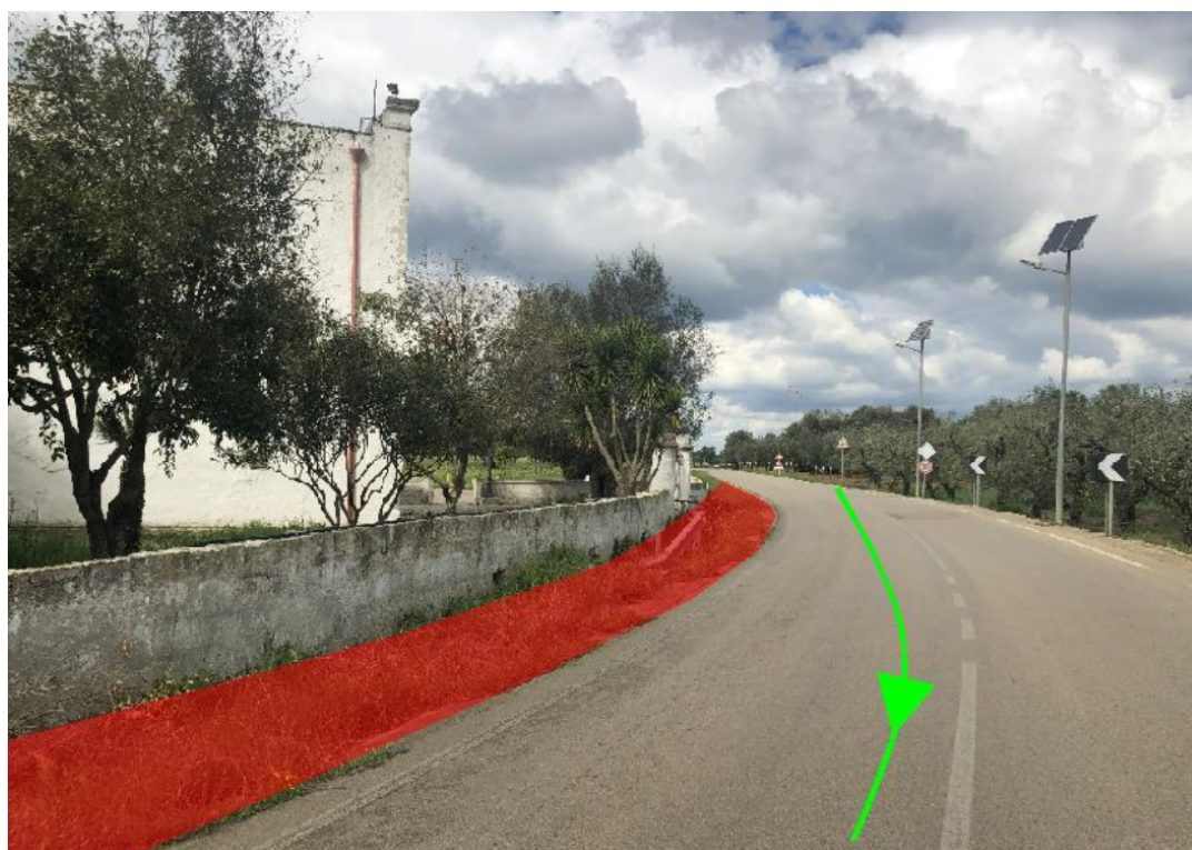
Intervento 6: E' previsto un piccolo allargamento della carreggiata fino al muro di confine.
