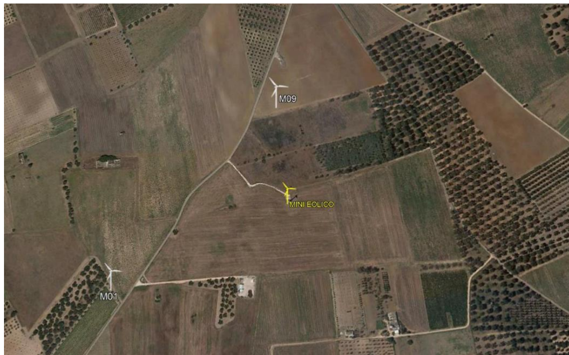
PARTICOLARE IMPIANTIO MINI EOLICO ESISTENTE A SUD DELL'ABITATO DI MESAGNE SP 82
