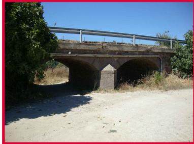
**Descrizione dell'opera d'arte esistente:** L'opera al km 64+438 della SS 293 "di Giba", è un ponte costruito in pietra di origine vulcanica, con due campate ad arco ribassato. L'unico pilone di appoggio si sviluppa su una fondazione in calcestruzzo e presenta un rostro di forma triangolare. Le specchiature sono realizzate in muratura irregolare compresa tra archi di imposta, rostri ed angolari delle spalle realizzati in conci squadri con forma regolare.
