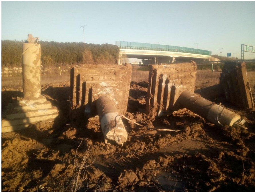
Figura 57- Esempio di rimozione della fondazione superficiale di un sostegno 220 kV
