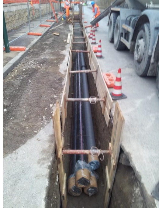
Figura 45 - Rinterro con posa delle tubiere
