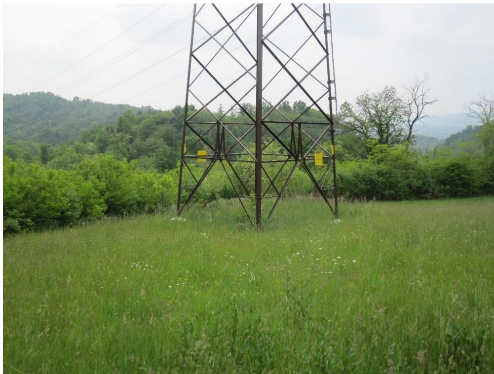
Figura 64 - Intervento di inerbimento sulle linee 132 kV della Val D'Ossola Sud
