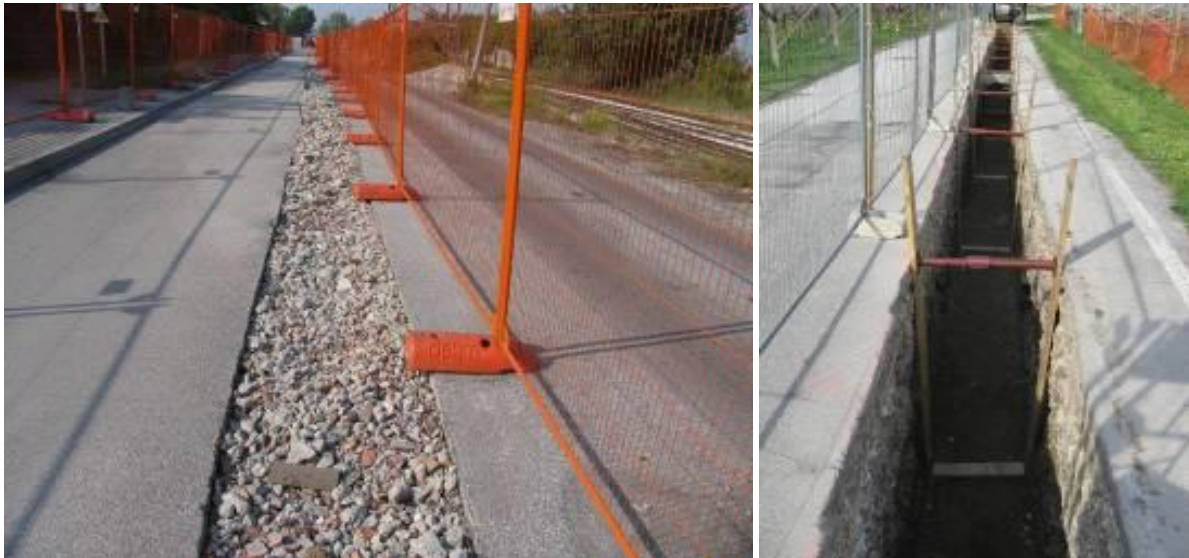
Figura 40 - Taglio dell'asfaltatura e scavo aperto
