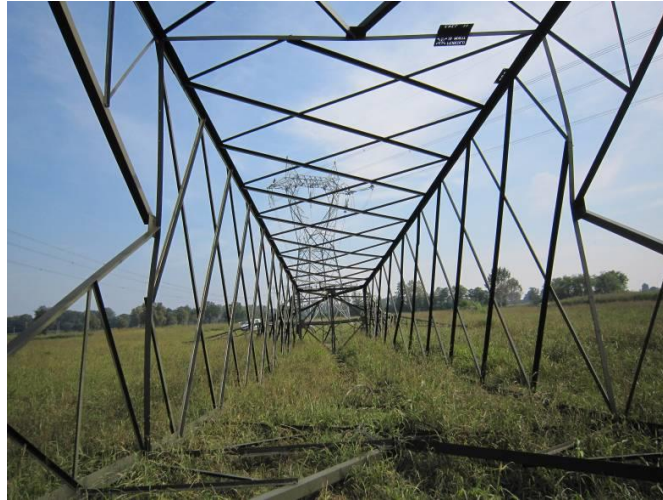
Figura 55 - Fasi demolizione di un sostegno a traliccio
