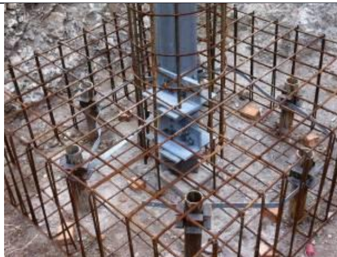
Figura 24 - Esempio di realizzazione di una fondazione su micropali tipo tubfix. Nell'immagine di destra si può notare il particolare del raccordo tra i tubolari metallici dei micropali con l'armatura del plinto di fondazione; al centro del plinto si nota il moncone del sostegno (elemento di raccordo tra il sostegno e la fondazione) il quale viene annegato nella fondazione stessa
