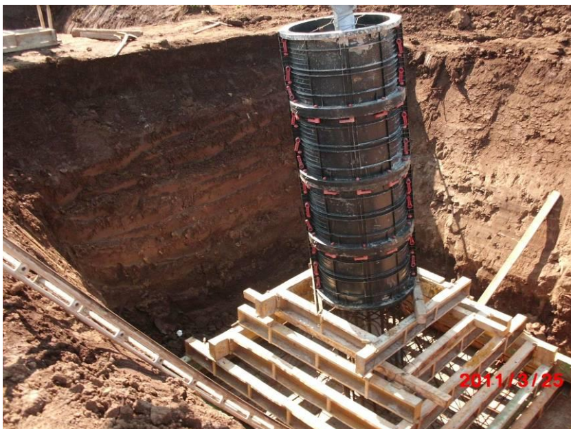
Figura 12 - Realizzazione di fondazioni superficiali tipo CR per un sostegno a traliccio. Nell'immagine si può osservare la fase di cassetatura
