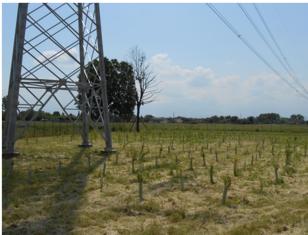
Figura 65 - Intervento di messa a dimora di alberi e arbusti sulla linea 380 kV Chignolo Po – Maleo
