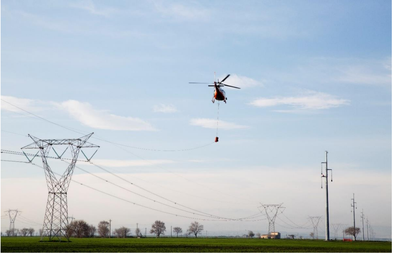
Figura 34 - Utilizzo dell'elicottero per la stesura della fune pilota
