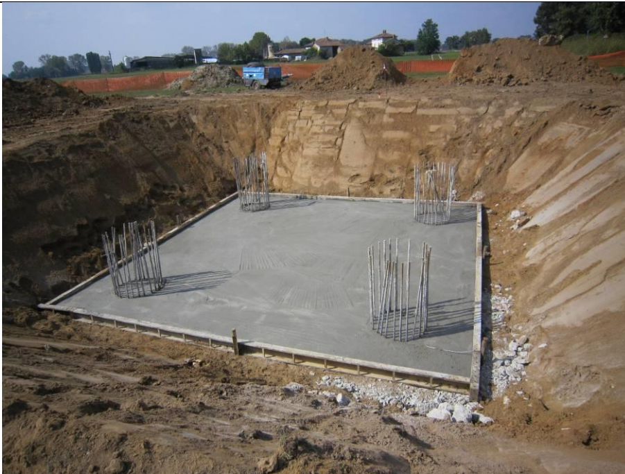
Figura 22 - Realizzazione di una fondazione su pali trivellati per un sostegno monostelo. Nell'immagine si può osservare una fondazione in fase di realizzazione. Si possono distinguere facilmente i quattro pali trivellati già realizzati e gettati (si osservano le "riprese" delle quattro gabbie metalliche) ed il piano di "magrone" sul quale impostare il monoblocco in cls
