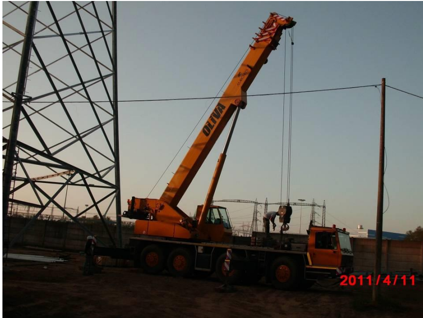
Figura 29 - Fasi di montaggio sostegno a traliccio
