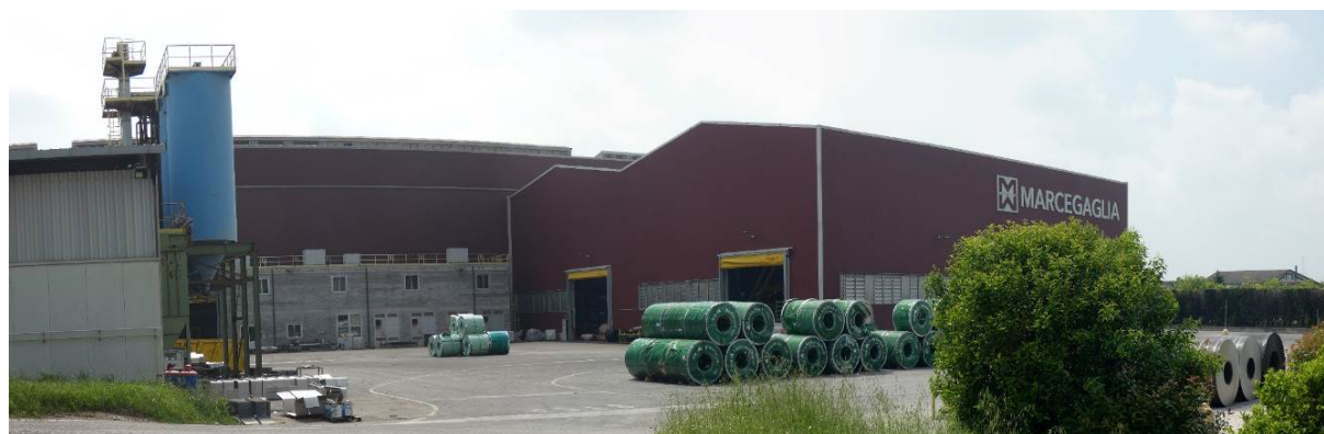
Figura 4.5/7 FOTO 2: vista da nord-est verso dell'area di intervento
