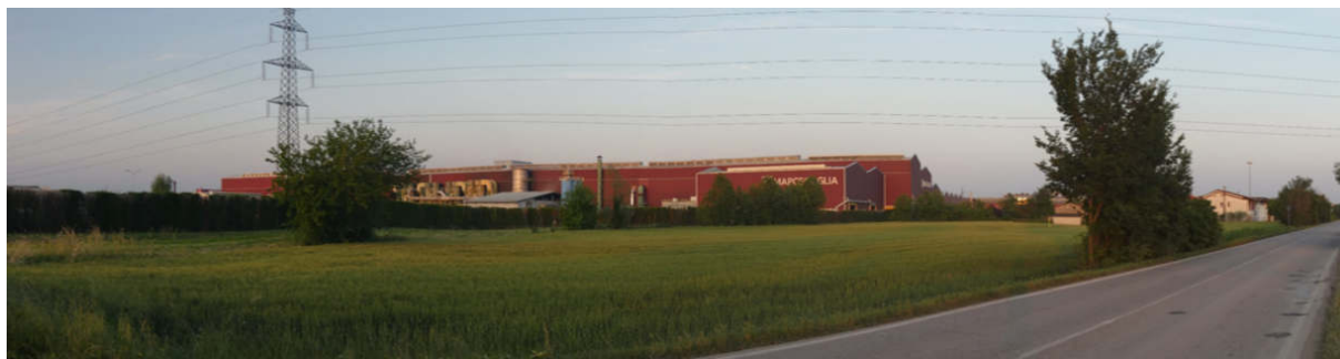
Figura 4.5/8 FOTO 3: ambiti agricoli in prossimità dell'area di intervento
