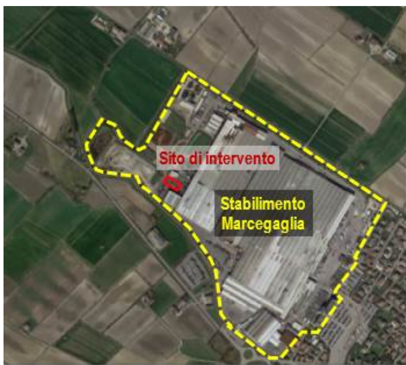
Figura 4.7/1 Vista aerea dello stabilimento Marcegaglia con indicazione del sito di prevista localizzazione dell'impianto in progetto
