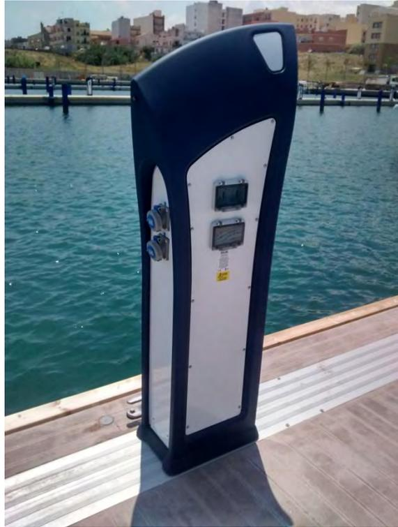
**Figura 5** – Particolari di arredo – Colonne erogatrici dei servizi
