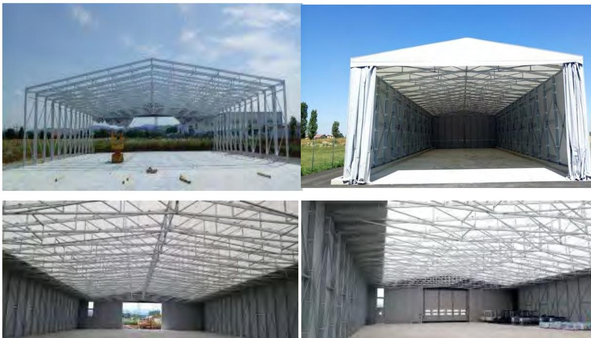
**Figura 1:** Particolari della struttura dei capannoni telescopici
