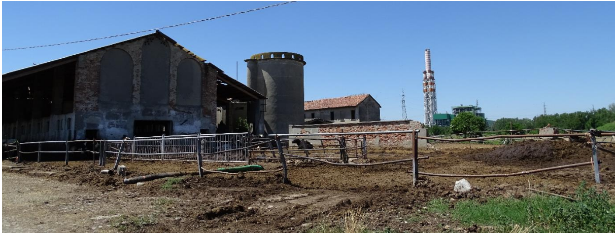
Figura 5.6: Cascina Zelasche Nuove a Sud della Centrale
