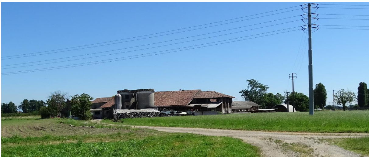
Figura 5.7: Cascina Gamorra ad Est della Centrale
