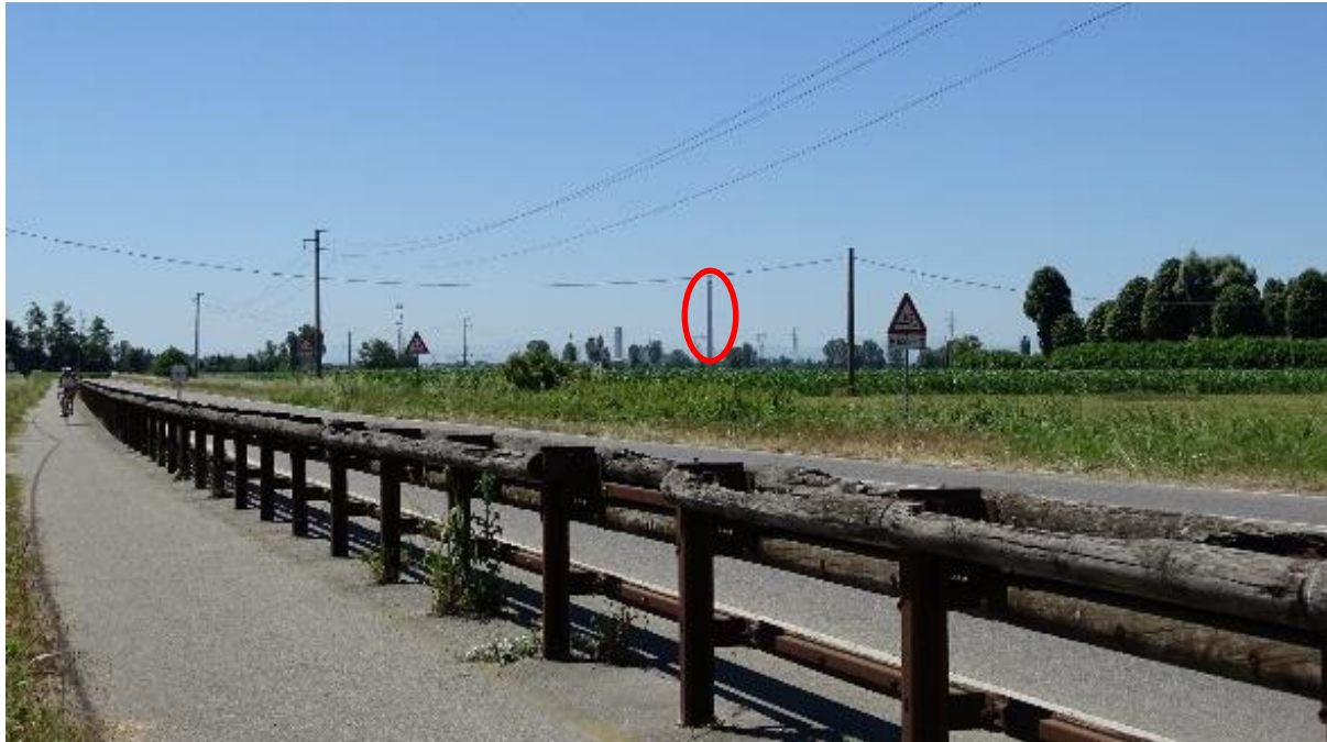
Figura 5.4: Camino della Centrale di Tavazzano e Montanaso – Vista da Villa Pompeiana
