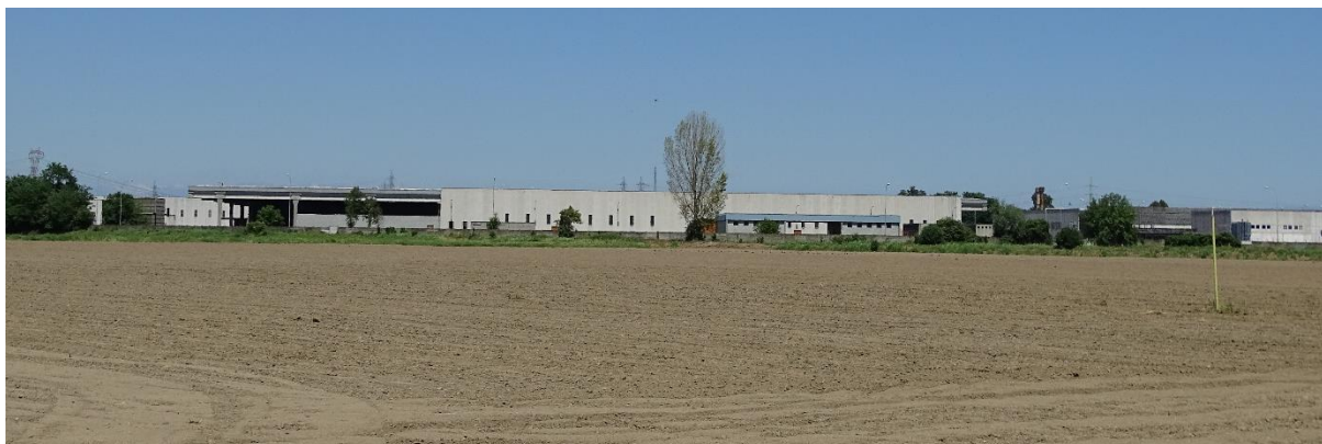
Figura 5.10: Strutture Produttive-Commerciali in Disuso o Parzialmente in Uso a Sud-Est della Centrale
