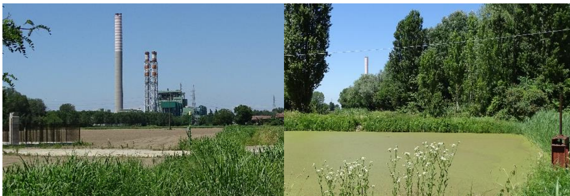
Figura 5.19: Vista da Sud-Sud Est verso la Centrale da 1.3 km (Sx) e da Sud da 1.4 km (Dx)
