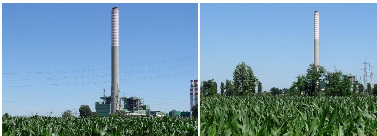
Figura 5.20: Vista da Ovest verso la Centrale da 600 m (Sx) e da 1.5 km (Dx)
