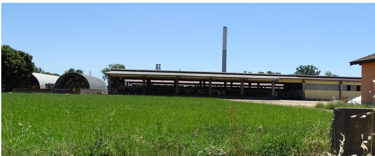
Figura 5.8: Stalle di Bovini in Località Mongattino a Nord della Centrale
